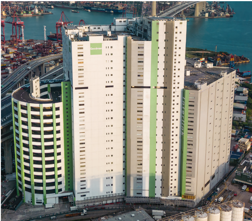
Goodman Interlink à Hong Kong : un bâtiment logistique de 22 étages.
