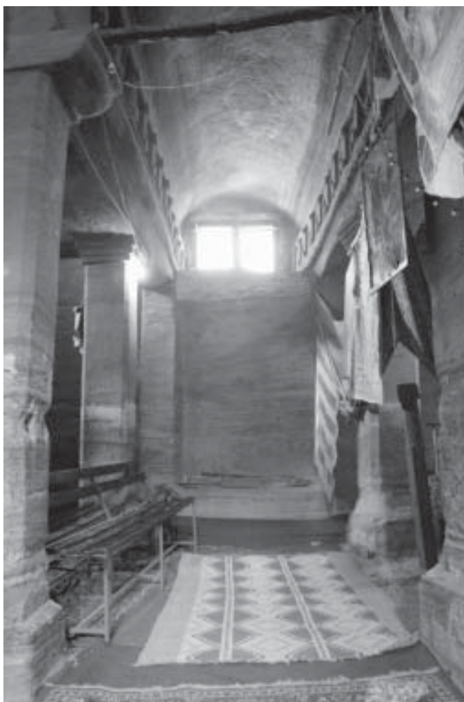
FIG. 11. Espace vide entre le haut de la paroi et le plafond au niveau de la fenêtre nord de Mika'el Amba.
