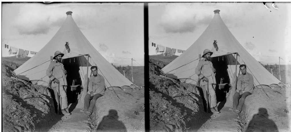
Figure 59. Sans titre, série « Mon camp de Tizratine et la route du Nador en construction », Boîte « Rif »
