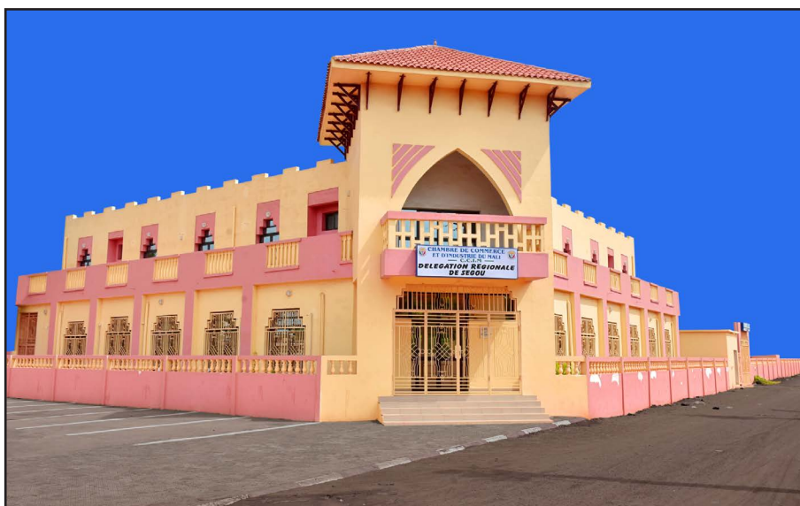
Figure 3. Chambre de commerce et d'industrie du Mali, délégation régionale de Ségou. Série Ségou ville d'architecture, 2018. © Oumarou Dembele.
