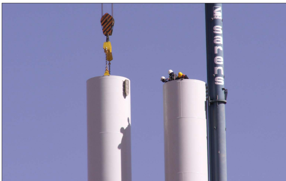
Image 2. Chantier d’éoliennes d’Ashegoda, Éthiopie, 2011
