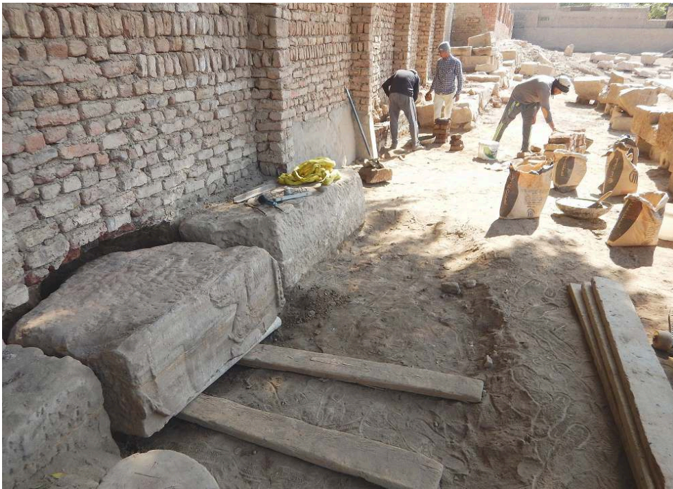
Fig. 19. Extraction du bloc 523 du mur romano-byzantin et consolidation du mur moderne (C. Thiers).
