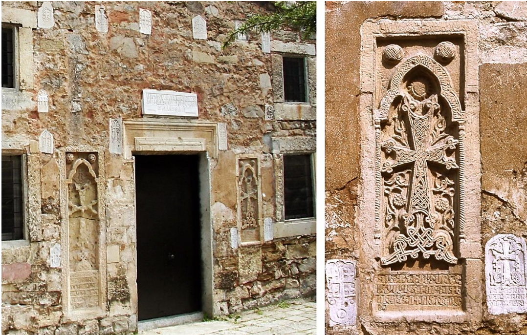
1a. Centre de la façade. Photo A. Džanov
