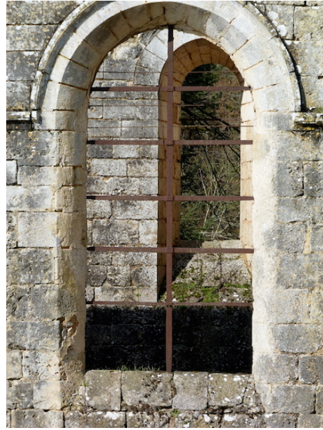
12- Nef, extérieur, baie
