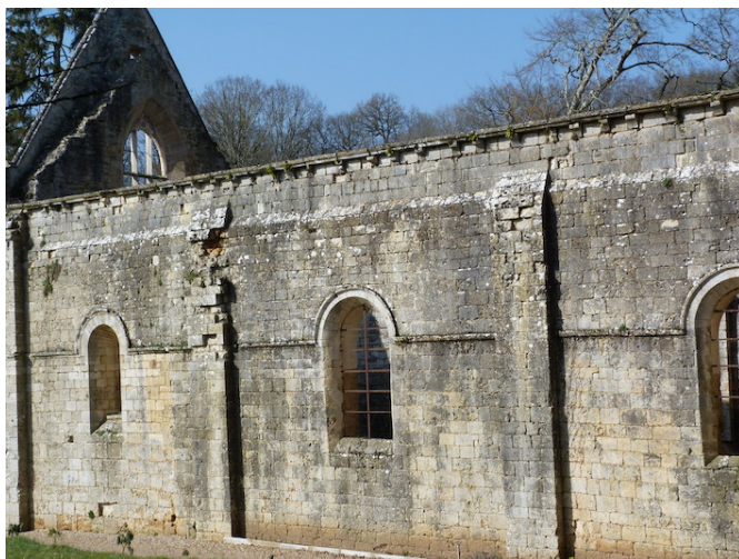
9- Gouttereau sud de la nef, extérieur
