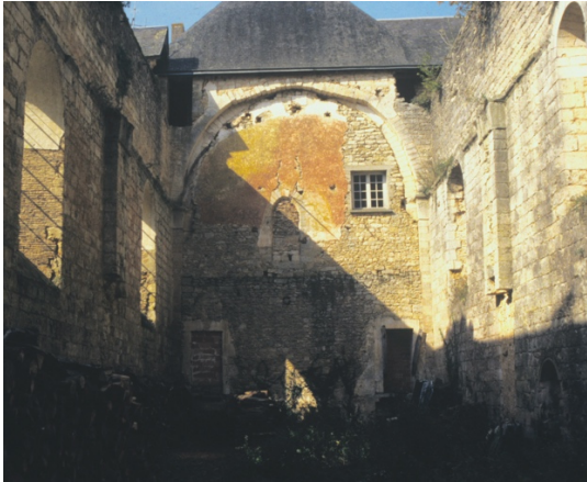
7- Cloison montée entre nef et croisée.
