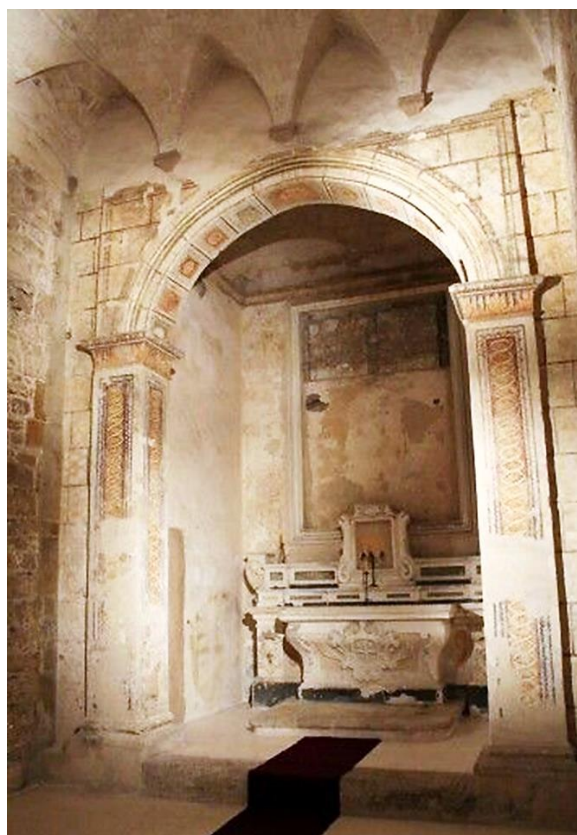
Fig. 14. Tarente, église Saint-André des Arméniens. Vue intérieure de l'abside. Photo en ligne pinterest.it
