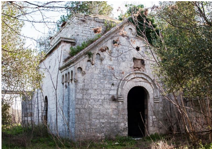
Fig. 5. Bari, église Saint-Georges des Martyrs. Vue générale du nord-ouest. Photo en ligne Ferruccio Cornicello et www.famedisud.it/salviamo-la-chiesa-di-san-giorgio-martire
