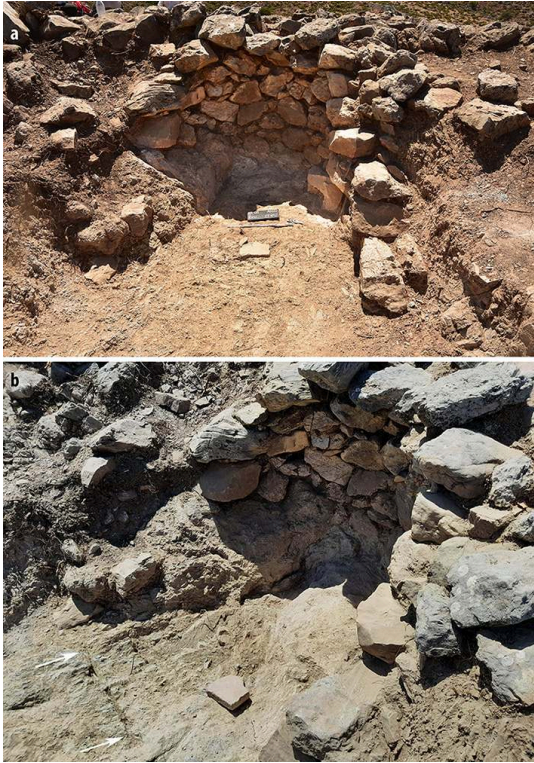
a. vue du Nord-Est ; b. vue du Nord montrant l'entaille de fondation dans le rocher.
