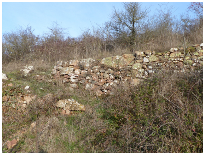
Exemple de restants d'un mur © Photo S Flandin, 2021
