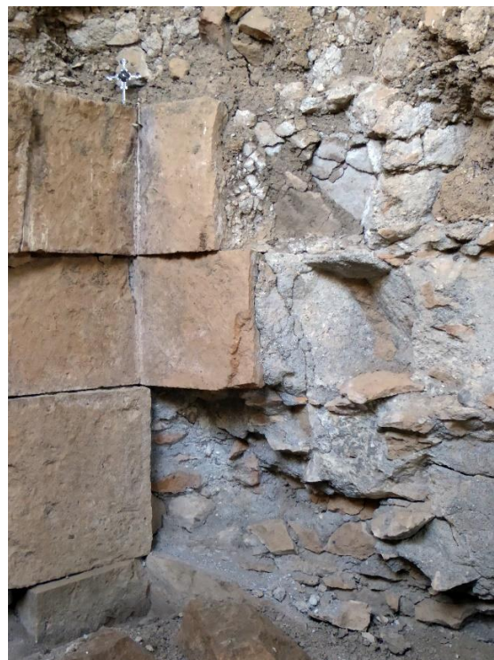
Fig. 39. Ereruyk, petit bâtiment dans le vallon (« mausolée »). Angle intérieur sud-est. Cliché A. Hartmann-Virnich, LA3M, 2015.
