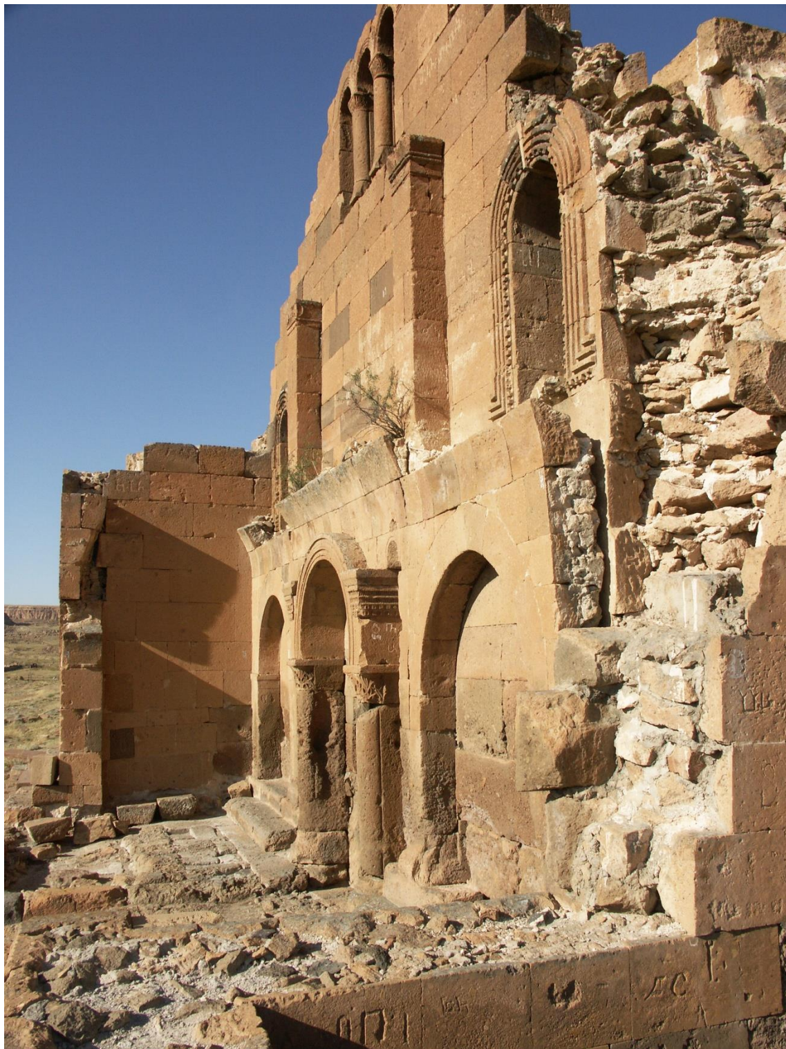
Fig. 8. Ereruyk, basilique. Façade ouest vue du sud-ouest. Cliché P. Donabédian, LA3M, 2013.
