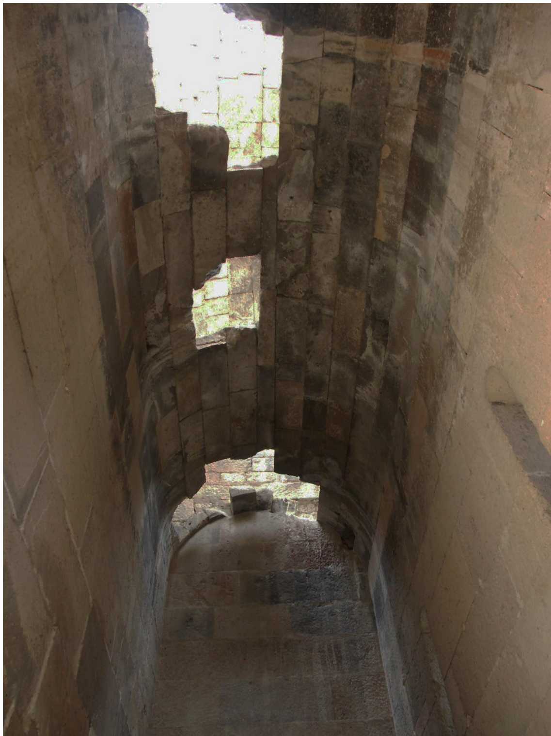
Fig. 11. Ereruyk, basilique. Pastophorion nord-est. Vue intérieure des deux voûtes superposées. Cliché P. Donabédian, LA3M, 2009.
