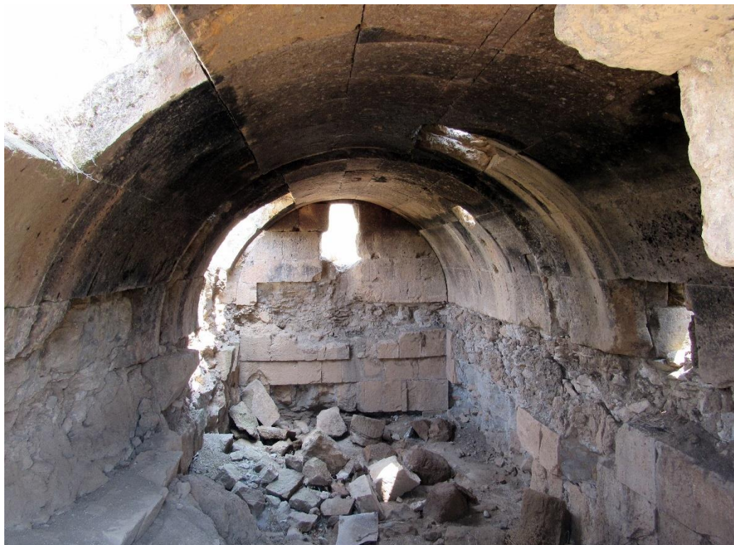
Fig. 37. Ereruyk, petit bâtiment dans le vallon (« mausolée »). Vue intérieure vers l'est. Cliché P. Donabédian, LA3M, 2015.
