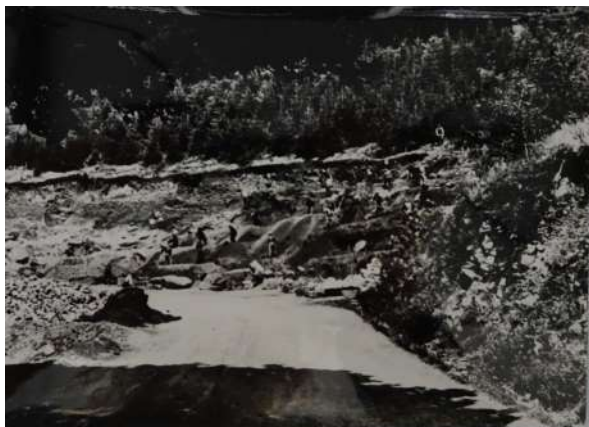
Fig. 85 : Dégagement en cours du front de taille vers 1941-42 (NATZ19_PH_ARCH_234, CERD).
