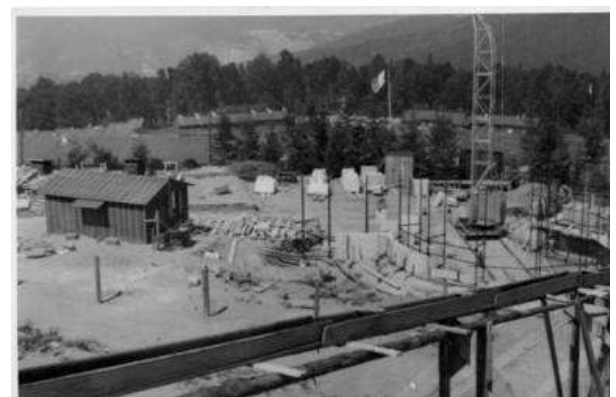
Fig. 66 : Photographies du chantier pendant la construction de la nécropole et du mémorial (IHOES).
