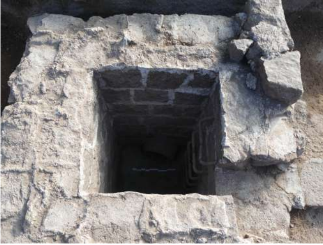
Fig. 469 : Détail du parement intérieur du regard, ELA 23 (photographie : J. Brangé).
