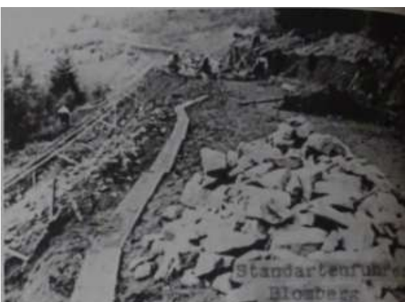
Fig. 84 : Construction de la route des ouvriers civils vers la carrière vers 1941 (NATZ19_PH_ARCH_398, CERD).
