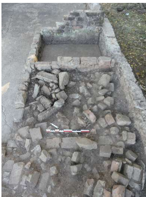
Fig. 419 : Comblement intermédiaire des bassins central et sud-ouest depuis le sud-ouest constitué des matériaux de démolition des murs des bassins (US 3293) depuis le sud-ouest, SD3A (photographie : M. Landolt).
