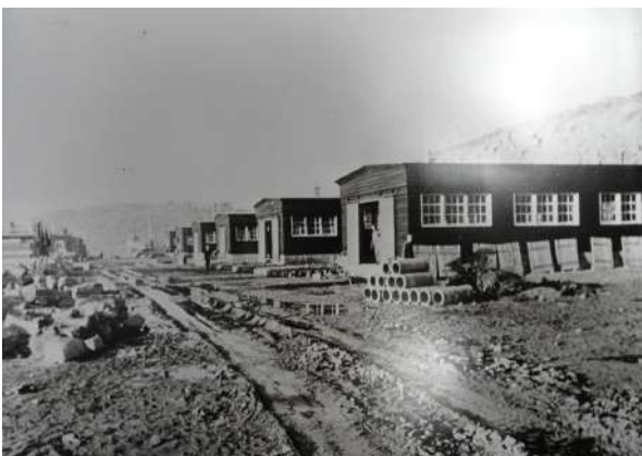
Fig. 318 : Carrière au printemps 1943. Toutes les halles du côté ouest ne sont pas encore construites (NATZ19_PH_ARCH_014, CERD).
