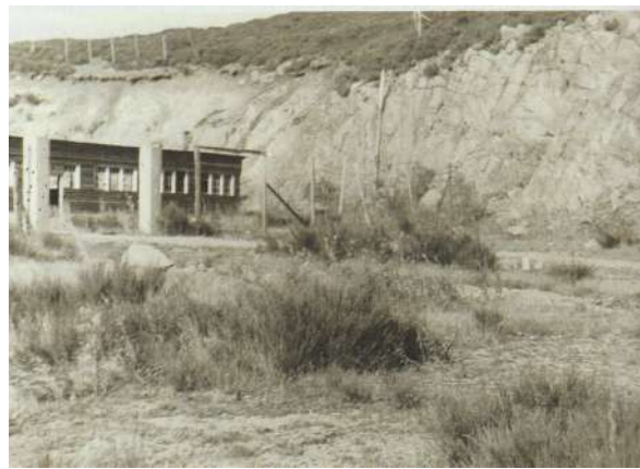
Fig. 104 : Entrée SE de la carrière vers 1947 (Collection Charles René, CERD).
