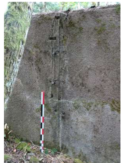
Fig. 214 : Gouttereau NE avec son arrivée électrique, prospection 2020 (photographie : J. Brangé).
