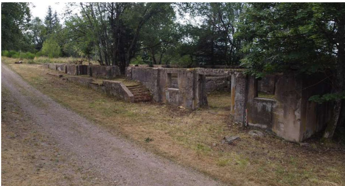
Fig. 138 : Vue du bâtiment dépôt (photographie : A. Vantillard).
