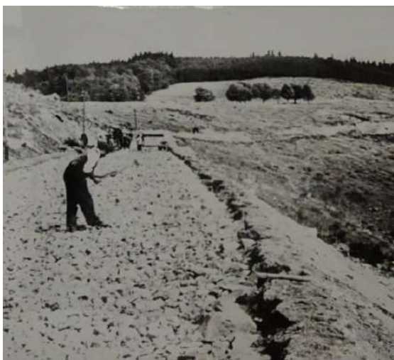
Fig. 26 : Construction de la route menant à la carrière pour les civils et les livraisons de matériaux, vers 1941 (NATZ19_PH_ARCH_243, CERD).
