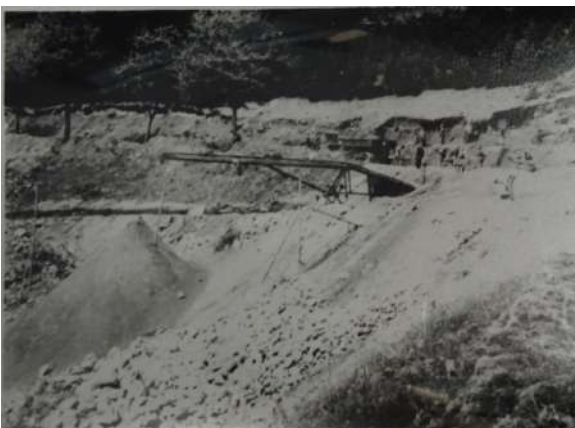
Fig. 83 : Construction de la route des ouvriers civils vers la carrière et création de la terrasse artificielle vers 1941 (NATZ19_PH_ARCH_175, CERD).
