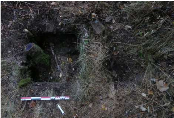
Fig. 508 : Trappe menant vers une pièce technique souterraine en béton du compresseur (photographie : J. Brangé).
