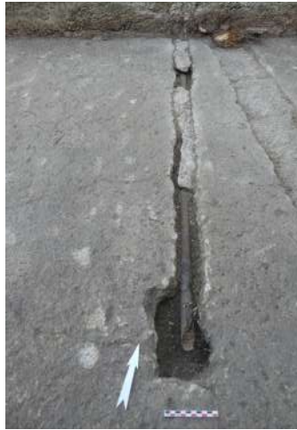
Fig. 386 : Alimentation électrique ELA 122.08 depuis le sud-est (photographie : M. Landolt).
