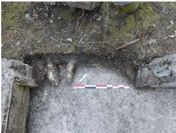
Fig. 235 : Vue de l'ouverture entre la pièce 12 et 14 (photographie : M. Landolt).
