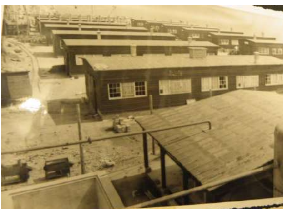
Fig. 98 : Halles et compresseur après-guerre (Collection particulière).
