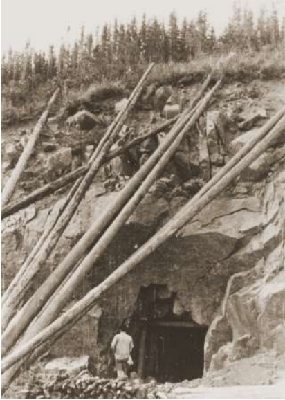
Fig. 102 : Entrée de la galerie 2, vers 1944 à la « Libération » (?) (NATZ19_PH_ARCH_378, CERD).
