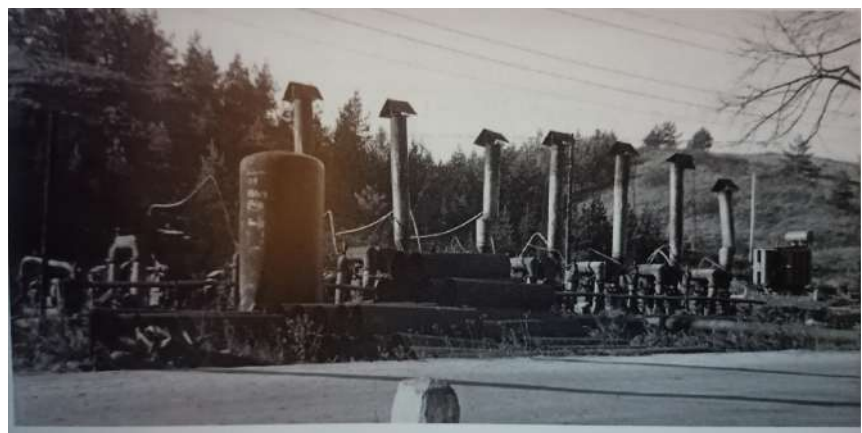
Fig. 513: Compresseur du chantier Jonastal près de Amstadt (Stadler et al. 2021, p. 71, Archiv Gedenkstätte Buchenwald ).
