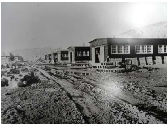
Fig. 92 : Construction en cours des halles au printemps 1943 ; 8 sont déjà en place ( Steinmetzhalle Frühjahr 1943 ) (NATZ19_PH_ARCH_014, CERD).
