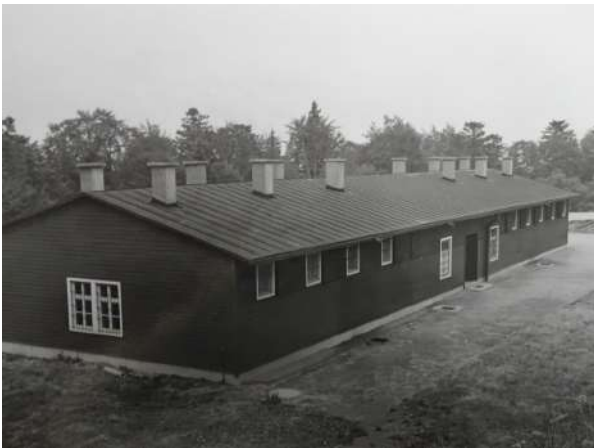
Fig. 519 : Bunker en 1976, gouttereau sud (NATZ19_PH_ARCH_194, CERD).
