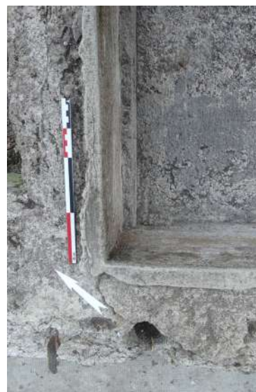
Fig. 245 : Détail du recouvrement de la plinthe bétonnée au niveau de l'angle ouest de la pièce 12 (US 4444 et 4445) (photographie : M. Landolt).
