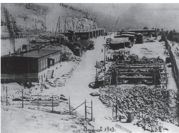
Fig. 93 : Construction en cours du dépôt en août 1943 ( August 1943 ) (NATZ19_PH_ARCH_093, CERD).
