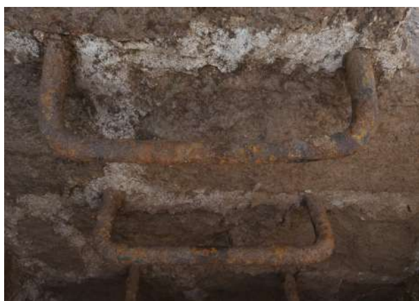
Fig. 476 : Détail du scellement de l'échelle, ELA 23 (photographie : J. Brangé).
