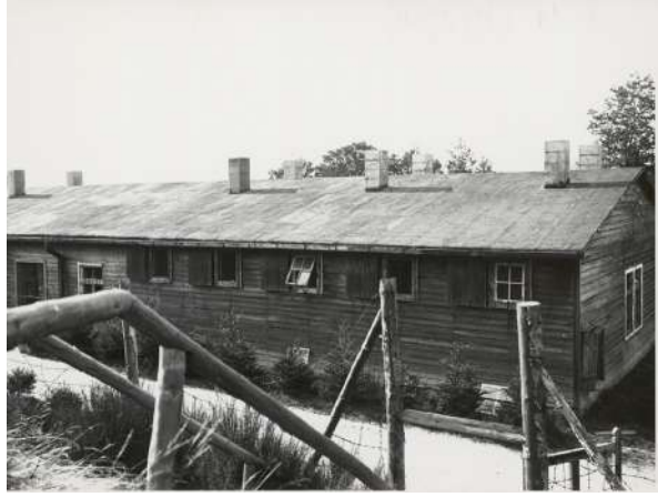
Fig. 516 : Bunker en 1951, gouttereau sud (NATZ19_PH_ARCH_282, DRAC Grand Est, Denkmalarbeit ).
