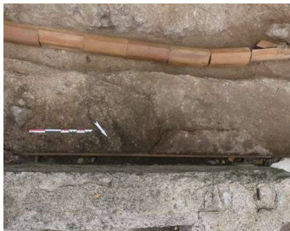
Fig. 359 : Rail inférieur du vantail gauche coulissant du portail arrière de la halle (US 3340) depuis le dessus, SD3C (photographie : M. Landolt).
