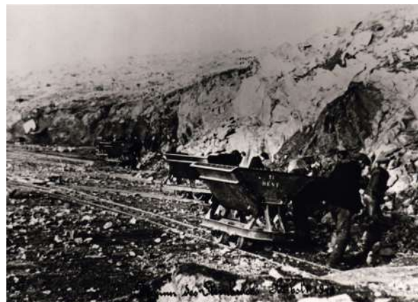
Fig. 86 : Travail en cours au niveau du front de taille au printemps 1941 ( Beginn des Steinbruchs Herbst 1941! ) (NATZ19_PH_ARCH_094, CERD).
