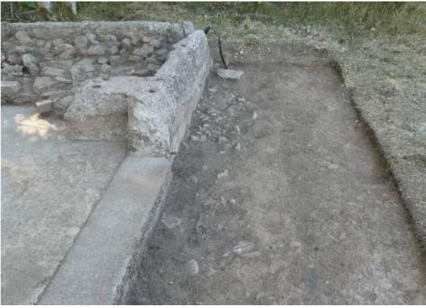
Fig. 404 : Comblement de la tranchée de récupération du dallage depuis le nord-ouest (US 3309), SD3E (photographie : M. Landolt).
