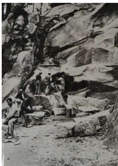
Fig. 87 : Travail en cours au niveau du front de taille vers 1941-1942 (CERD).
