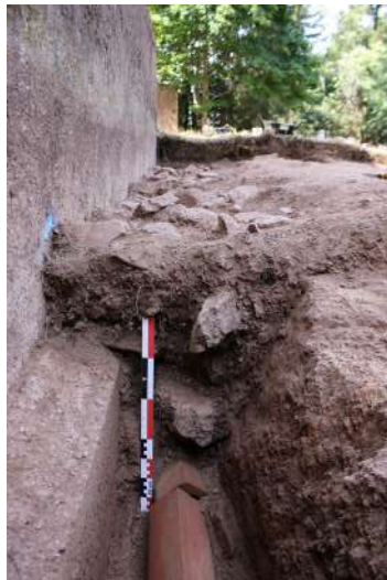
Fig. 210 : Réseau électrique avec ses chapeaux en terre cuite et comblement de la tranchée de fondation (photographie : L. Aymard et J. Brangé).
