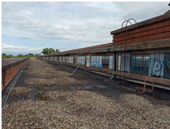
Fig. 312 : Toit de l'usine List (photographie : J. Brangé).
