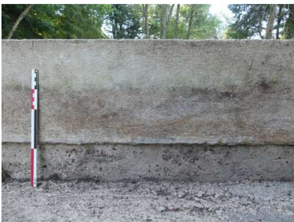
Fig. 250 : Vue de la plinthe bétonnée recouverte d'un badigeon beige-jaune (photographie : M. Landolt).
