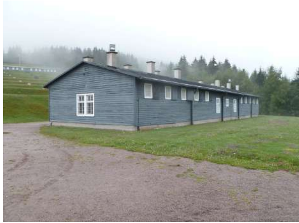
Fig. 520 : Bunker en 2011, gouttereau nord (NATZ19_PH_ARCH_322, Bottineau 2011).
