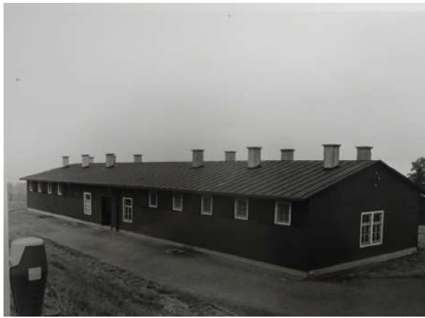
Fig. 518 : Bunker en 1976, gouttereau sud (NATZ19_PH_ARCH_211, CERD).
