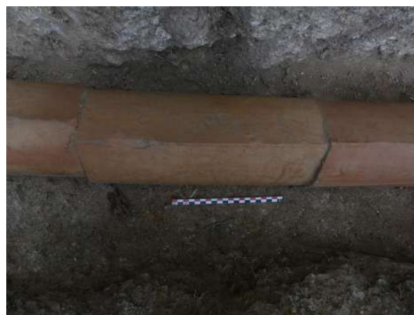
Fig. 372 : Détail d'un chapeau en terre cuite de protection du réseau électrique au niveau du sondage 3C depuis le sud-ouest (photographie : M. Landolt).
