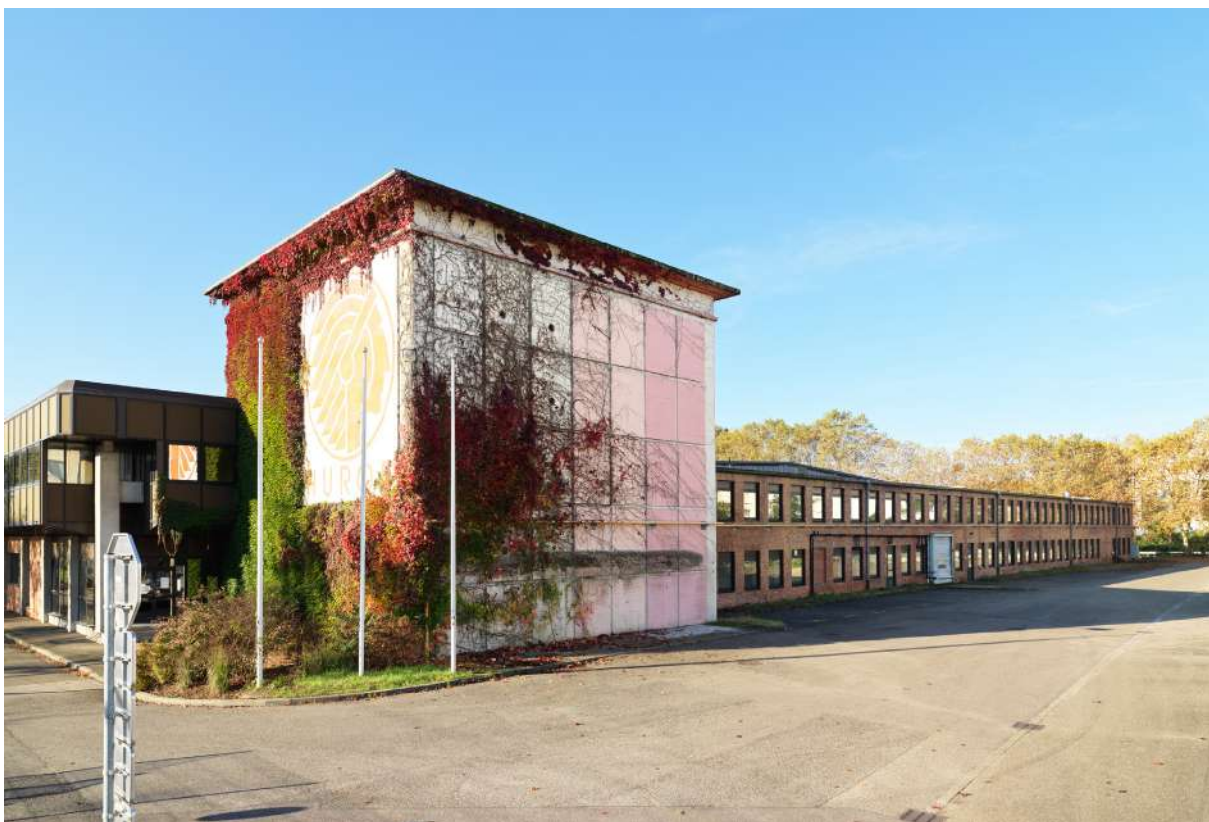
Fig. 291 : Abri antiaérien et usine des de la Magdeburger Werkzeugmaschinenfabrik à Illkirch-Graffenstaden (photographie : Région Grand Est, Inventaire Général, Siméon Levaillant).
