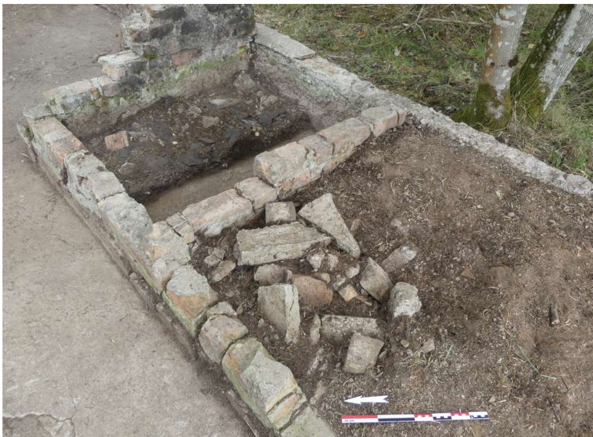
Fig. 422 : Comblement supérieur des bassins central et sud-ouest depuis l'ouest (US 3312), SD3A (photographie : M. Landolt).
