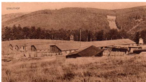
Fig. 28 : Vue de la construction du camp haut au début de l'année 1942 par les déportés (NATZ19_PH_ARCH_002, carte postale édition Lucien Kohler, CERD).
