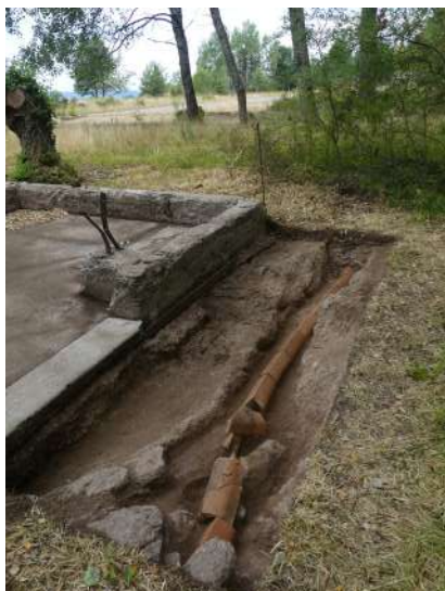
Fig. 369 : Tranchée de réseau électrique au niveau du sondage 3C depuis le nord-est (photographie : M. Landolt).
