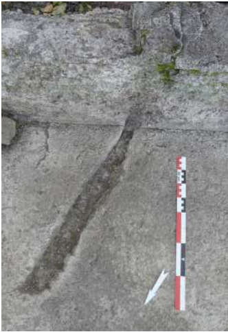
Fig. 385 : Alimentation électrique ELA 122.10 depuis le nord-ouest (photographie : M. Landolt).
