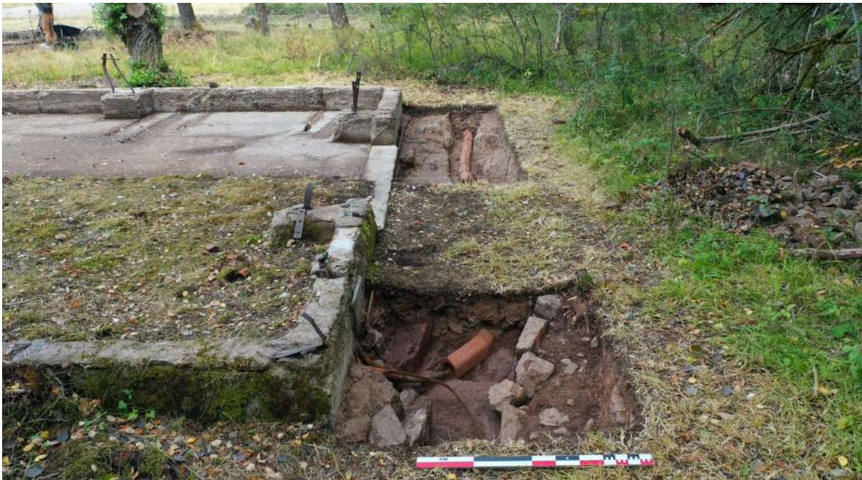
Fig. 349 : Sondages 3C et 3D à la fin de la fouille (photographie : A. Vantillard).
