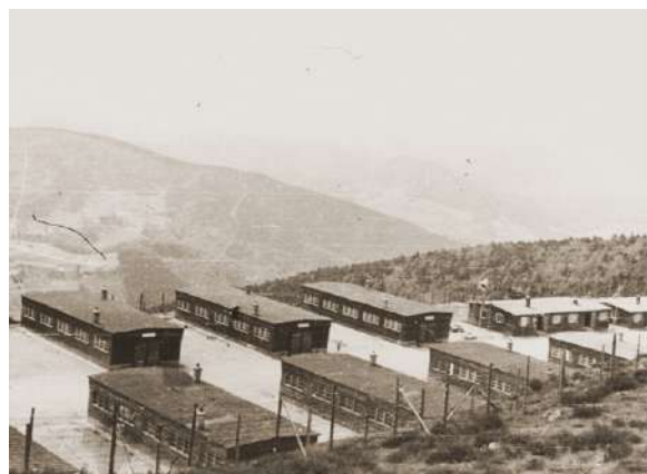
Fig. 97 : Halles, baraque des gardiens et cantine vers fin 1944-début 1945 (NATZ19_PH_ARCH_096, CERD et USHMM).
