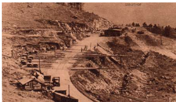
Fig. 29 : Exploitation de la carrière au printemps 1942. On peut remarquer les rampes d'évacuation des déchets de taille (NATZ19_PH_ARCH_001, carte postale édition Lucien Kohler, CERD).
