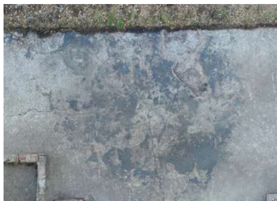
Fig. 379 : Traces de toile goudronnée fondue ou de goudron sur la dalle de la halle 122 depuis le dessus (photographie : M. Landolt).
