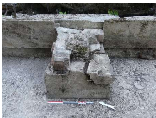
Fig. 248 : Vue de la base du conduit de cheminée depuis le sud-ouest (US 3450, 3452 et 3481) (photographie : M. Landolt).
