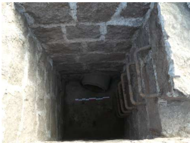
Fig. 474 : Echelle métallique à l'intérieur du regard, ELA 23 (photographie : J. Brangé).
