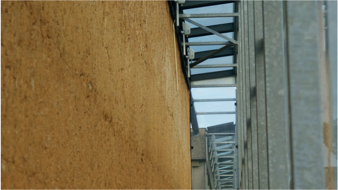
Mur trombe en bauge de 35 mètres de long par 3,5 mètres de haut et 70 cm d'épaisseur, façade sud de l'atelier mécanique, campus de Beaulieu, université de Rennes 1, Yves-Marie Maurer Atelier d'architecture et Catherine Proux Architecte associée, entreprise Maison en terre (réalisation : 2009-2011).
