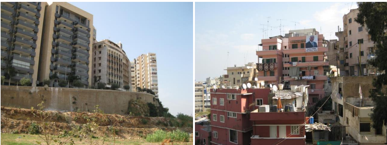
Figure 11 : Sioufi : construction sur le rebord et immeuble en dénivelé
