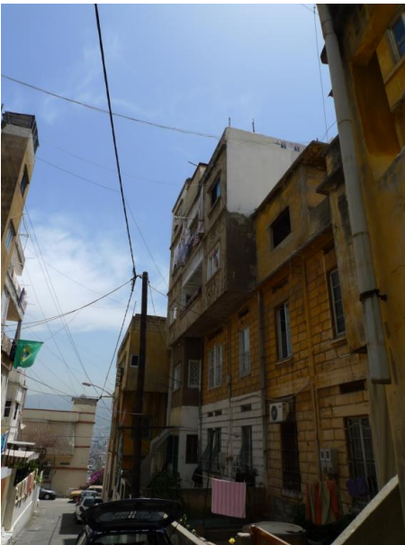
Figure 25 : Sioufi : ajout d'étages sur maisons en maçonnerie
