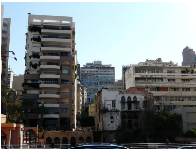
Figure 28 : hétérogénéité des hauteurs d'immeuble.
