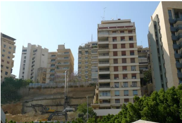
Figure 23 : Sioufi : construction immeubles en dénivelé
