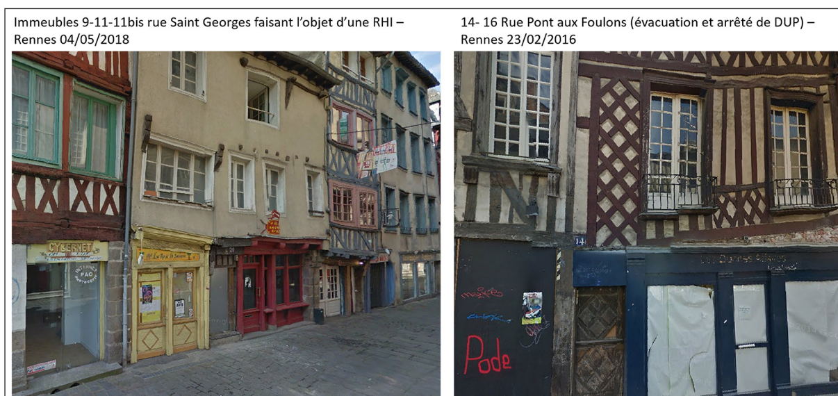
Figure 2. Dégradation et insalubrité d'une partie des logements du centre historique. Façades qui flanchent et déshérence des parties communes. Source : Clichés personnels (2017-2019)
