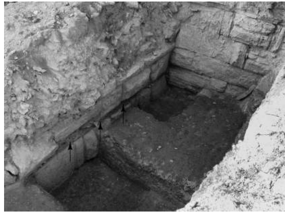
Fig. 7 — Angle entre la tour 7 (au fond) et la courtine qui se dirige vers la porte est et le port (à gauche). Les flèches indiquent la couche d'abandon de la construction. Cliché P. Aupert / EFA.
