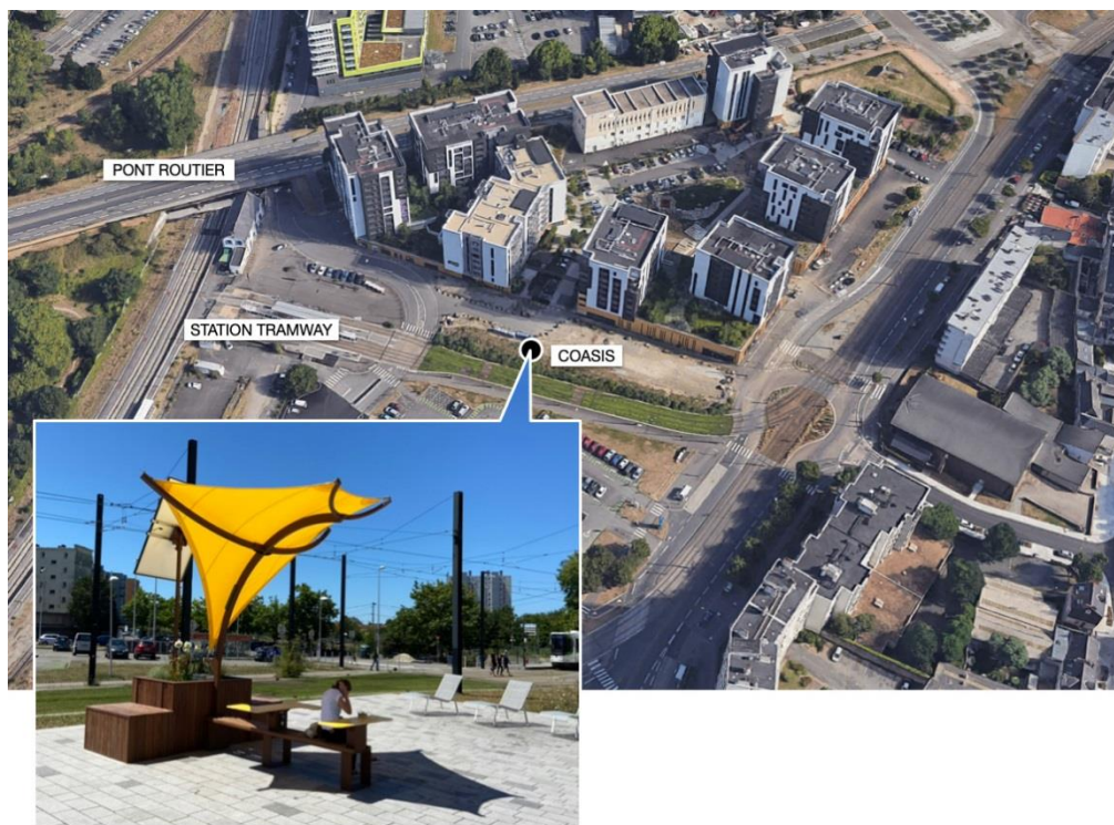
Figure 2. Le mobilier Coasis dans un espace public urbain de la métropole nantaise. © Photo Coasis I. Requena / AAU-Crenau. © Photo aérienne Google Maps (la photo aérienne ne reflète pas l'aménagement définitif de la zone). Coasis furniture in an urban public space in Nantes Metropole. Photo Coasis I. Requena / AAU-Crenau. Aerial photo from Google Maps (the aerial photo does not reflect the final layout of the area).
