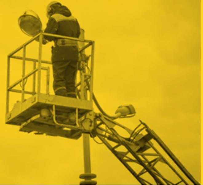
Figura 23: Reemplazo de luminarias por dispositivos LED.
