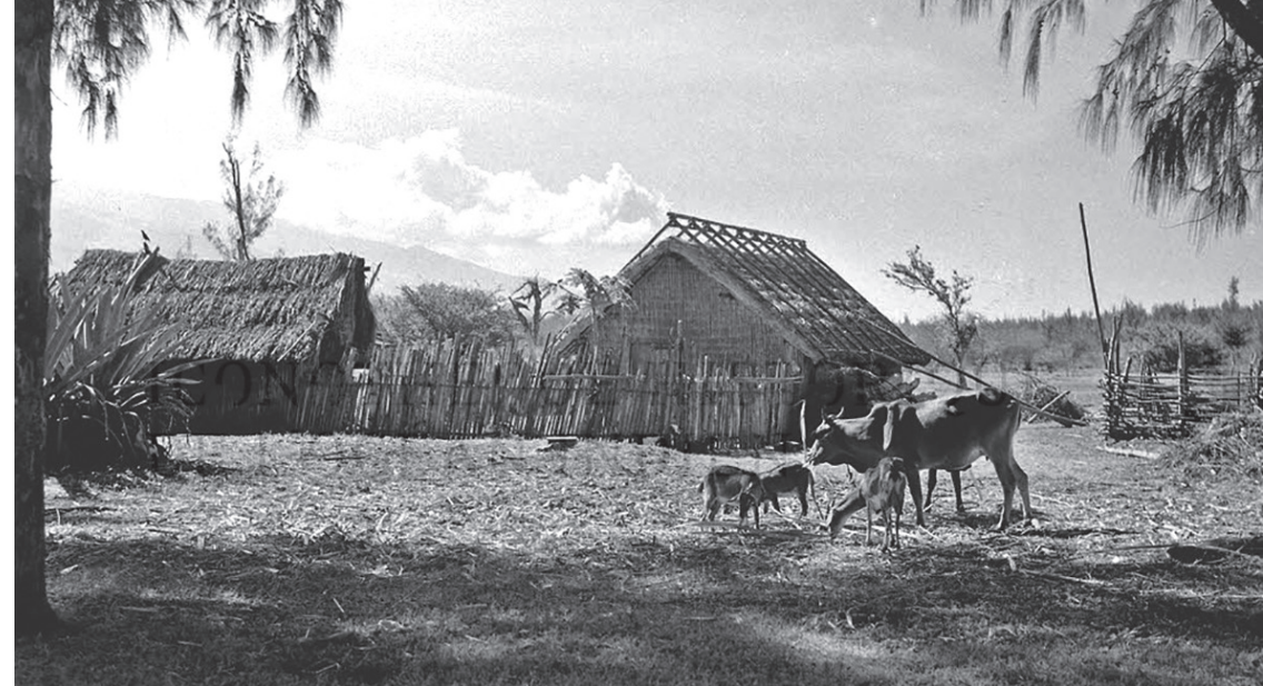
Albany, Case de pêcheur sous les filaos à l'Hermitage les Bains, 1950
