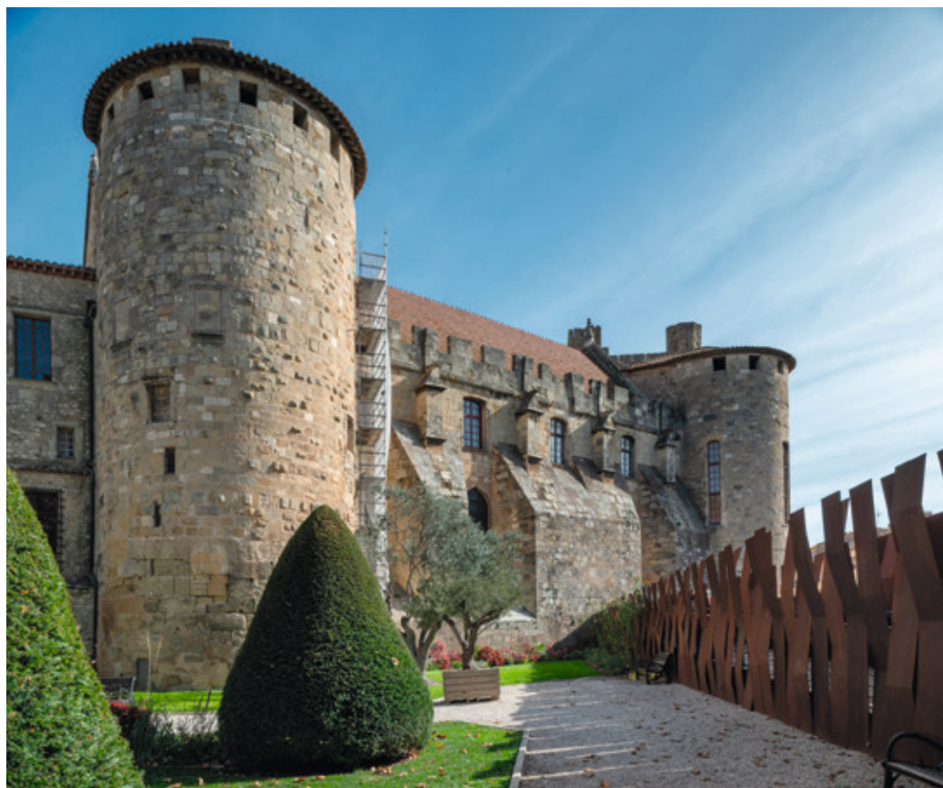
Fig.3 Courtine et tours attribuées à l'enceinte de l'Antiquité tardive dans les murs du palais neuf de l'archevêché de Narbonne.
