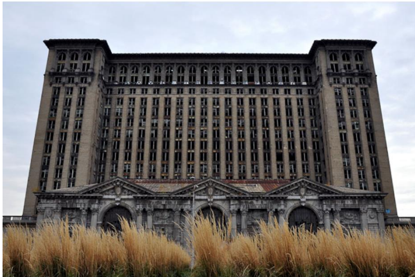
Figure 1 : Siège d'usine désaffectée à Detroit ( https://www.lepoint.fr/automobile/detroit-se-declare-en-faillite-18-07-2013-1706281_646.php#11 )
