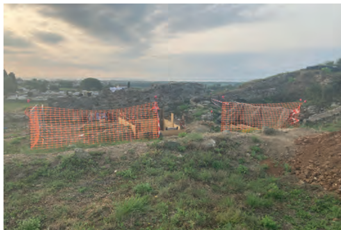
Balisage des abords du sondage de la Zone 1
