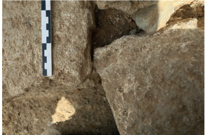
Fig. 6 : Détail de la jonction entre les parements intérieurs de la courtine méridionale RMP3087 (MR3087) et de la courtine orientale RMP1119 (MR1119) (photo : P. Fontaine)
