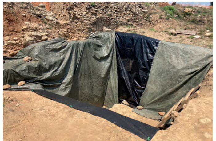
Mise en place de bâches de protection en fin de fouille dans le sondage de la Zone
