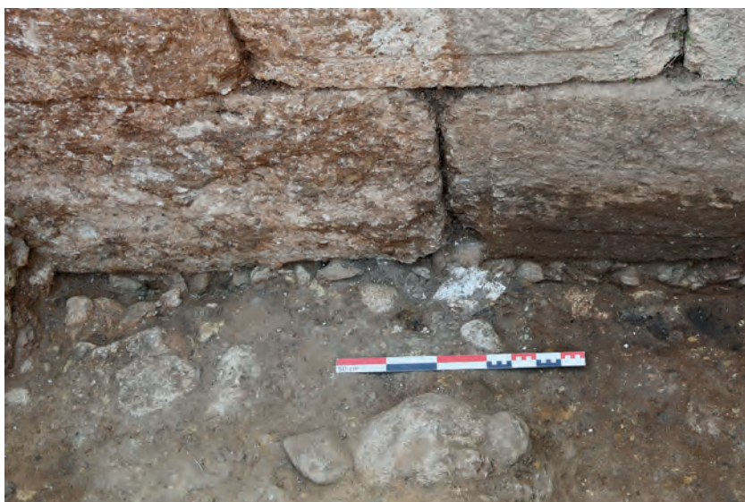
Fig. 13 : Vue de détail depuis l'Est du radier de fondation (2133) et de la base du parement oriental (3005) de la tour TOUT3090 (photo : E. Gailledrat).
