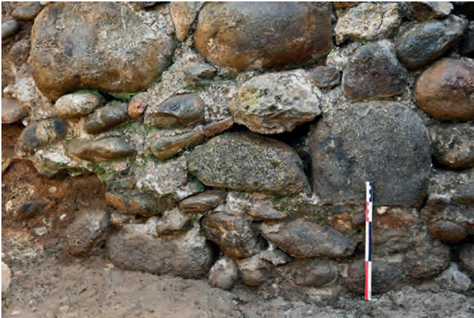
Fig. 58 : Vue de détail, depuis le sud, de la partie inférieure du mur MR3145, de la limite entre la partie fondée de ce mur et de l'élévation. (photo : J. Bertaut)
