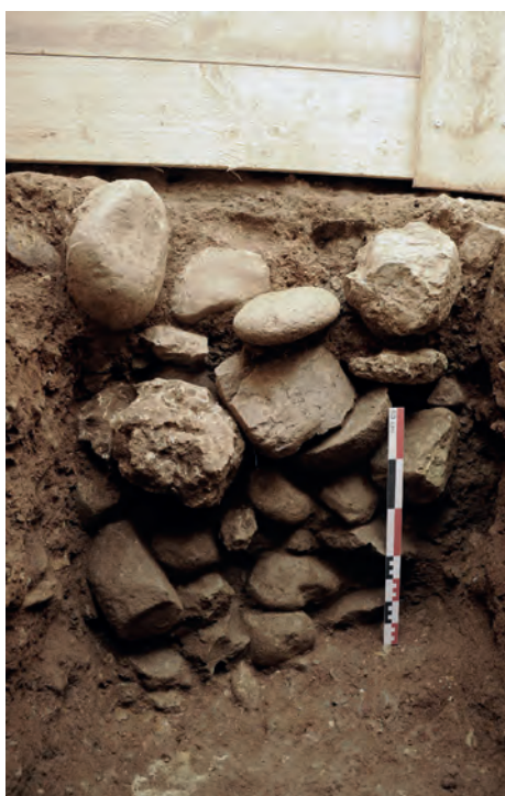
Fig. 19 : Vue en coupe du radier (1189) du mur MR1190 dans la face sud du sondage (photo : A. Vacheret).
