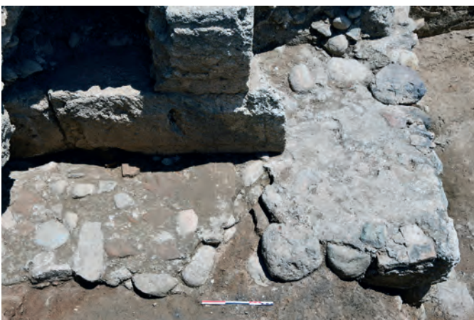
Fig. 60 : Vue depuis l'ouest de la fissure/lézarde, visible au niveau au sommet du mur MR3145. (photo : J. Bertaut)
