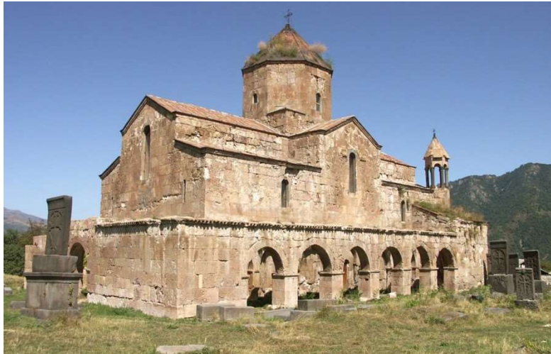
FIG. 7 : ODZOUN, EGLISE (VI E ET VIII E SIECLES). VUE GENERALE DU SUD-OUEST. PHOTO AUTEUR
