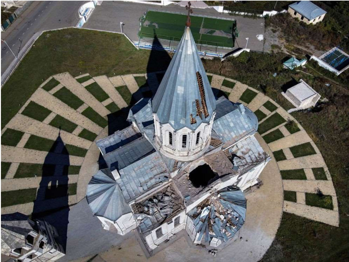
FIG. 66. CHOUCHI, CATHEDRALE SAINT-SAUVEUR (1868-1887). DOMMAGES CAUSES INTENTIONNELLEMENT ET SANS JUSTIFICATION, AU DOME EN OMBRELLE, A LA VOUTE DU BRAS SUD ET AUX TOITS, LE 8 OCTOBRE 2020. PHOTO EN LIGNE WIKIPEDIA
