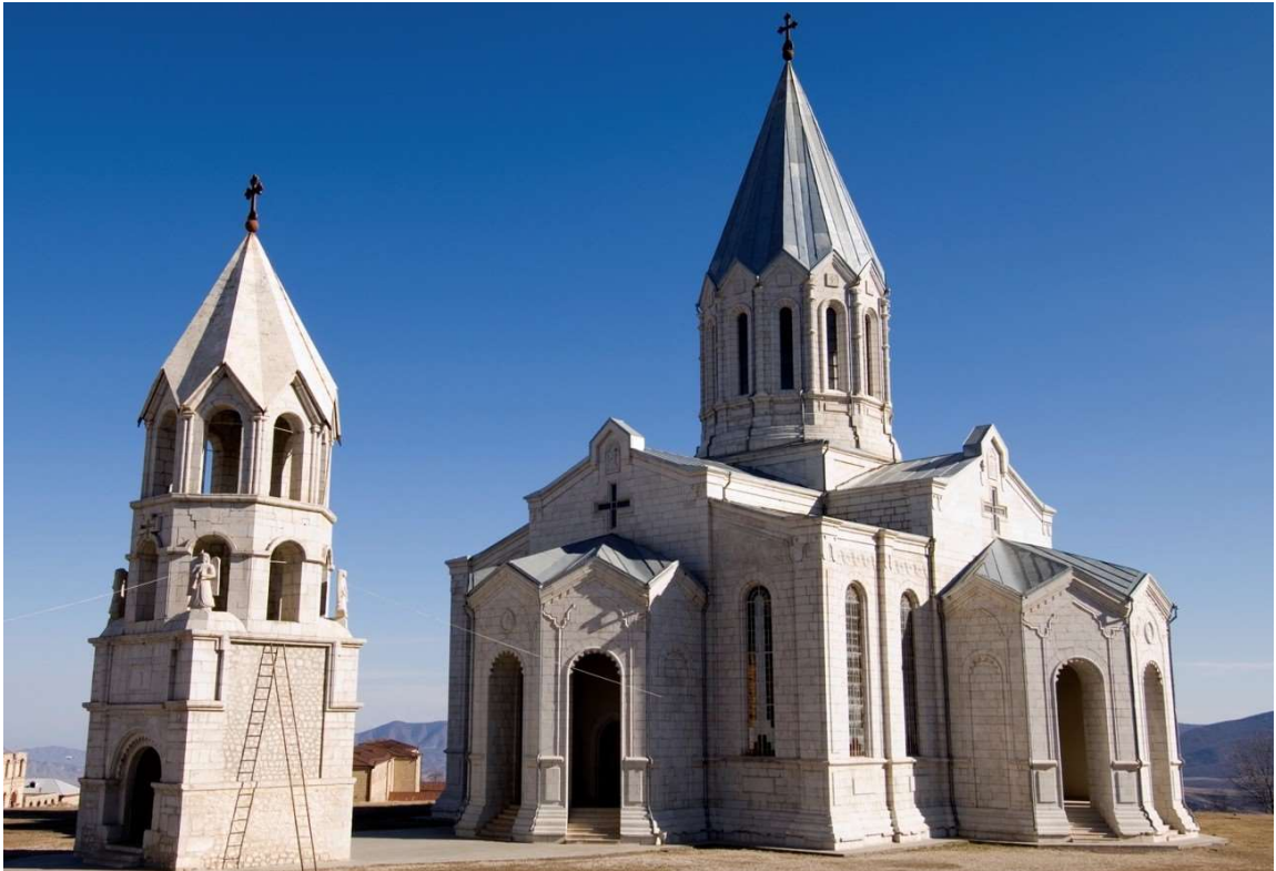
FIG. 65. CHOUCHI, CATHÉDRALE SAINT-SAUVEUR (1868-1887), DITE GHAZANTCHETSOTS, ŒUVRE DES ARCHITECTES AVETIS YARAMICHENTS ET SIMEON TER-HAKOBIANTS, PRÉCÉDÉE À L'OUEST DU CAMPANILE (1858). VUE DU SUD-OUEST. PHOTO HRAÏR HAWK KHATCHERIAN
