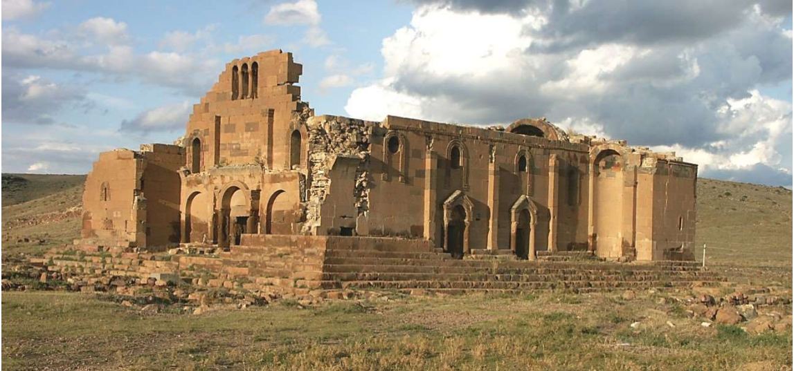
FIG. 30 : BASILIQUE D'EREROUYK/EREROYK' (CA. VI e S.). VUE GENERALE DU SUD-OUEST. PHOTO AUTEUR
