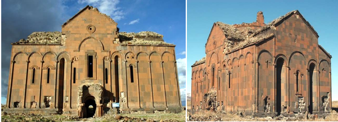
FIG. 44. ANI, CAPITALE DU ROYAUME ARMENIEN DES BAGRATIDES (961-1045), CATHEDRALE (989-1001). FAÇADE SUD ET VUE DU SUD-EST. PHOTOS AUTEUR
