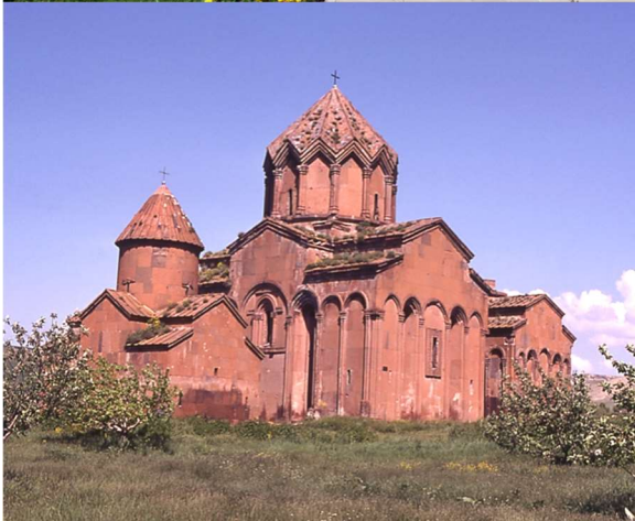
FIG. 43. PERIODE DES ROYAUMES (X e -XI e s.). EN HAUT : KARS, CATHEDRALE SAINTS-APOTRES (CA. 930-943), VUE DU SUD-EST ; EN BAS : MONASTERE DE MARMACHEN (988-1029), VUE DU SUD-EST. PHOTOS AUTEUR
