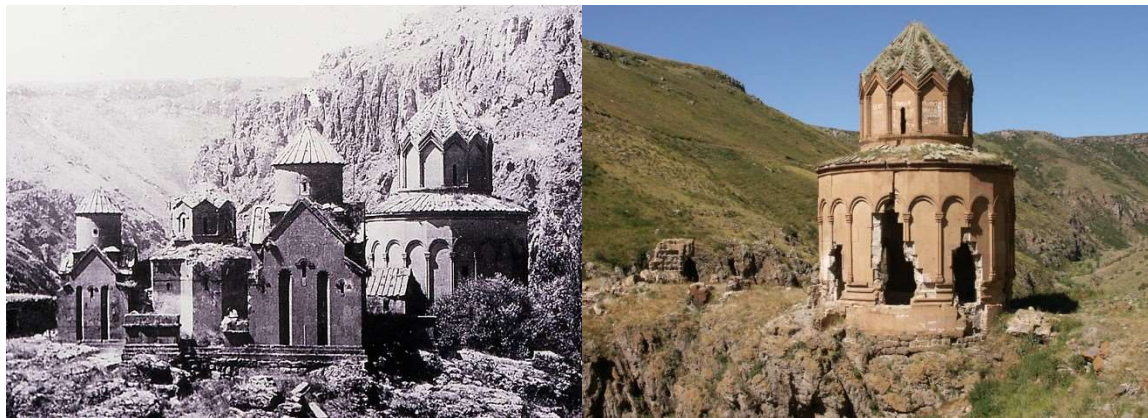
FIG. 62. MONASTÈRE DE KHETZKONK (XI e SIÈCLE), DETRUIT PROBABLEMENT VERS 1950. ENSEMBLE MONASTIQUE, PHOTO D'ARCHIVE, FIN XIX e S. À DROITE : L'ÉGLISE PRINCIPALE, ST-SERGE (1024), SEULE PARTIELLEMENT CONSERVÉE, TRÈS MENACÉE, CAR GRAVEMENT ENDOMMAGÉE. PHOTO AUTEUR
