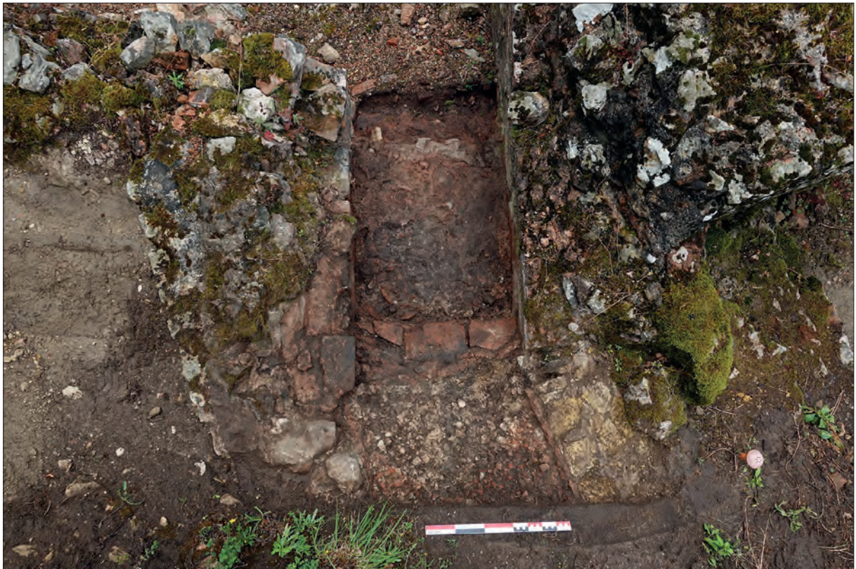
Fig. VI.3-31 – Vue zénithale depuis le nord-est du canal exutoire de la conduite d'eau supérieure de l'abside 1002 © Cliché M. Bellanger, juin 2023.
