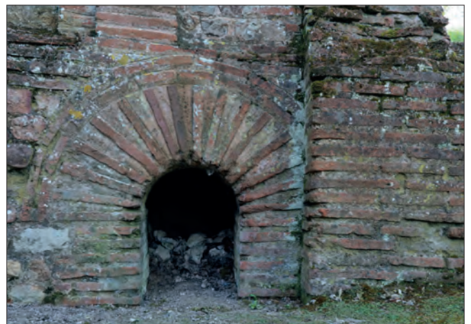
Fig. VI.3-13 - Détail du débouché nord de la conduite inférieure de l'abside 1002 © Cliché X. Favreau, mars 2021.
