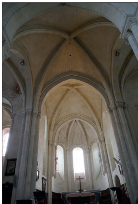
Fig. VII.4.13 - Vue générale intérieure du transept et du chœur.
