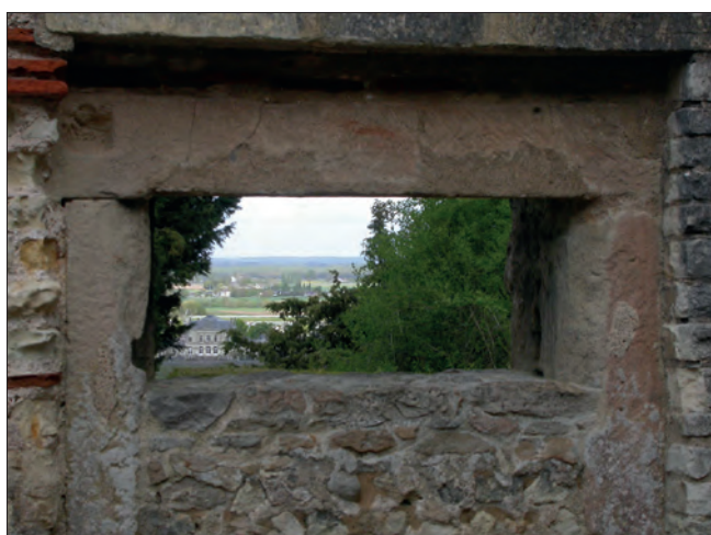
Fig. IV-20 - porte antique intégrée dans le mur nord de la nef de l'église Saint-Eusèbe, vue de l'intérieur : linteau et jambages monolithiques © Cliché L. Déodat 2018.
