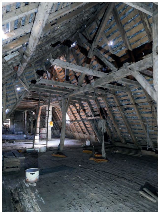
Fig. VII.3-6 - Vue générale de la charpente du volume principal, prise du sud vers le nord © Cliché E. Litoux.
