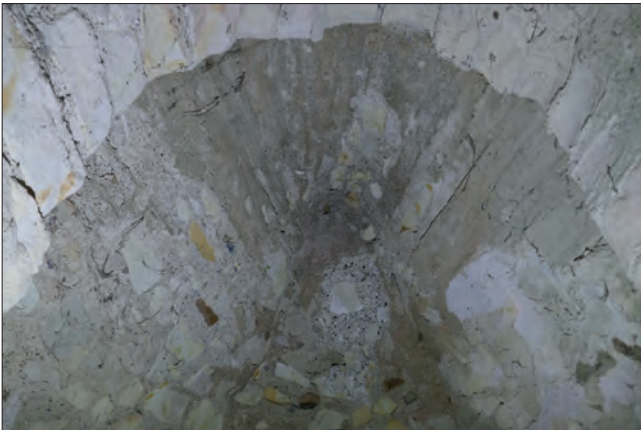
Fig. VII.4.25 - Voûte de l'escalier.
