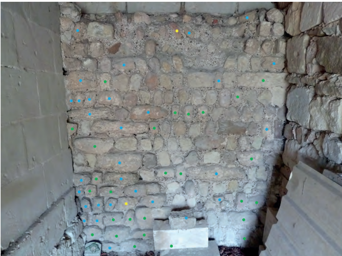
Fig. VII.5-5 - Fragments de sarcophages réemployés dans le parement intérieur du mur septentrional de l'église Saint-Pierre, au niveau de la portion visible à l'est de la chapelle : calcaire SP1 en bleu, calcaire SP2 en jaune et calcaire indéterminé en vert © Cliché A. Polinski, 2023.
