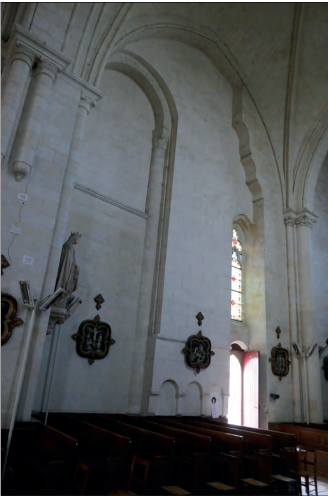
Fig. VII.4.29 - Le retrait correspondant au clocher, décalé vers l'ouest par un encorbellement.
