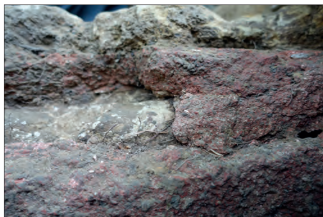
Fig. VI.2-48 - Détail sur le quart-de-rond sud de la paroi : on voit clairement l'enduit qui englobe la maçonnerie © Cliché L. Déodat 2023.
