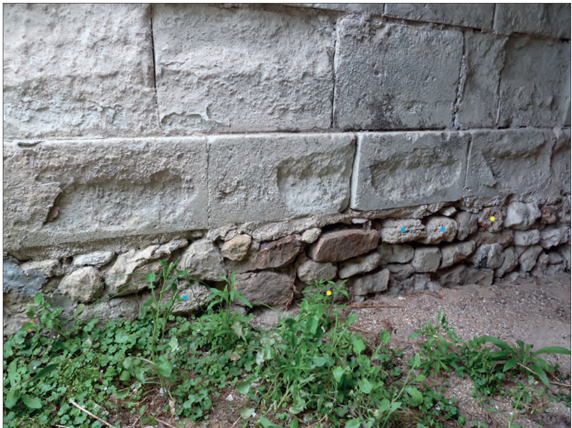
Fig. VII.5-9 - Fragments de sarcophages réemployés dans le mur oriental sous la chapelle moderne : calcaire SP1 en bleu et calcaire SP2 en jaune © Cliché A. Polinski, 2023.
