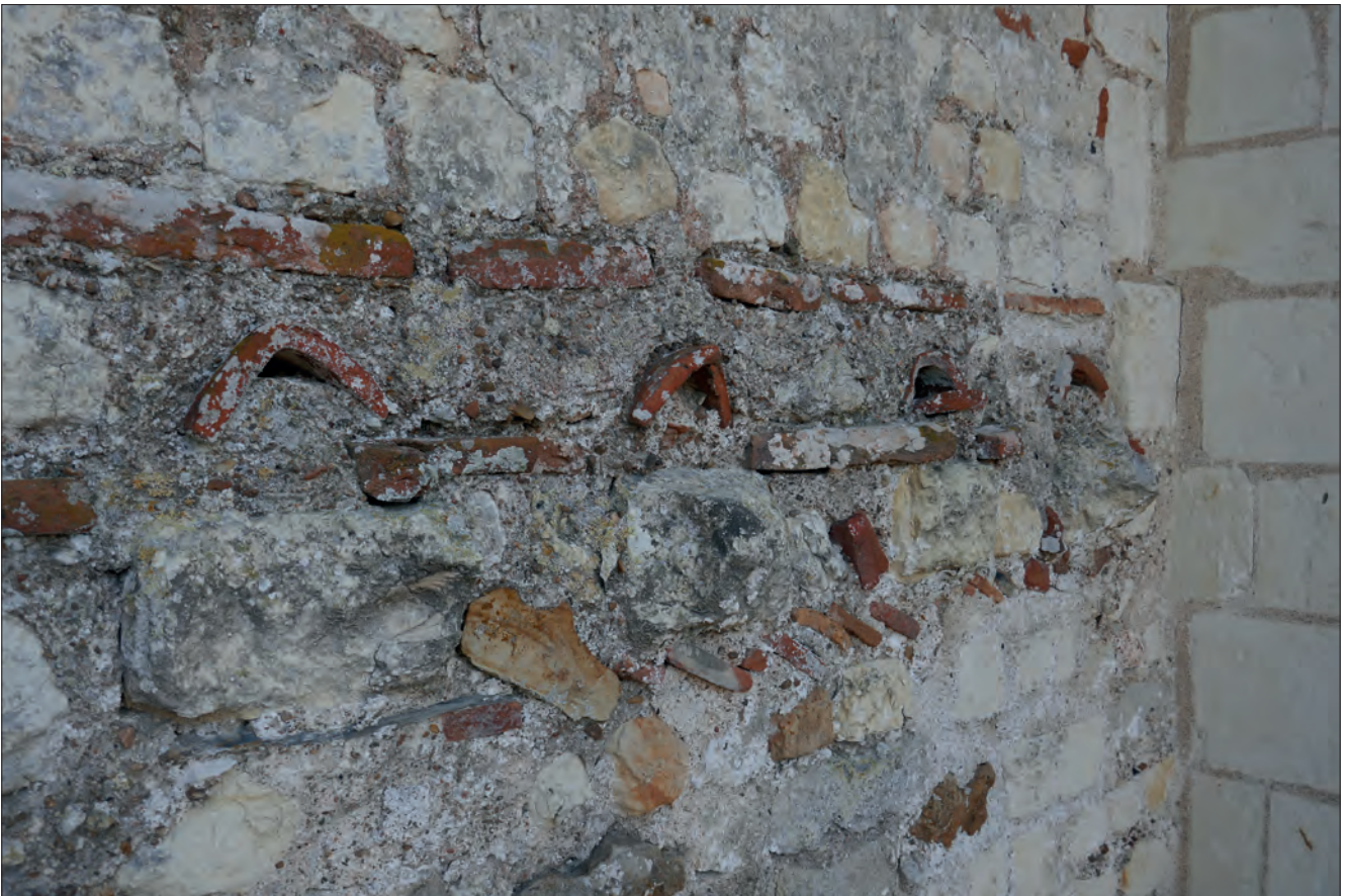
Fig. VII.4.19 - Détail de la corniche à modillons 40 001.
