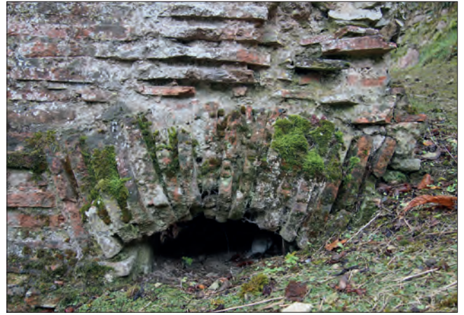
Fig. VI.3-12 - Détail du débouché ouest de la conduite inférieure de l'abside 1002 © Cliché X. Favreau, octobre 2021.
