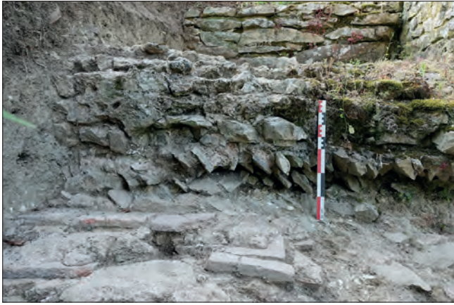
Fig. VI.3-39 – Détail des fondations du mur 1001 dans la partie nord du sondage 06 © Cliché X. Favreau, juin 2023.
