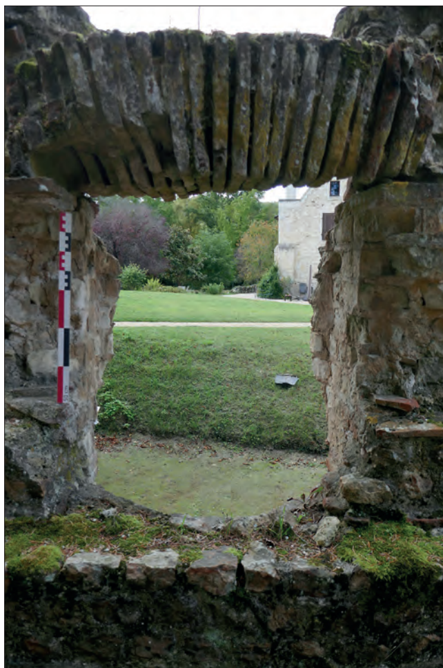
Fig. VI.3-16 - Vue depuis l'extérieur de l'abside de l'une des baies du registre supérieur de l'abside 1002 et de sa couverture en briques © Cliché A. Remy, octobre 2021.
