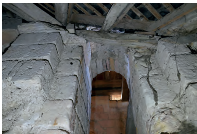
Fig. VII.4.28 - Arc de l'étage du clocher 40 007.
