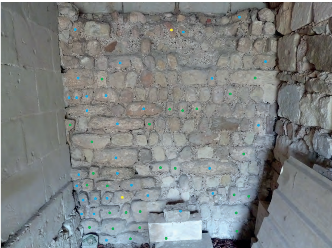
Fig. VII.5-5 - Fragments de sarcophages réemployés dans le parement intérieur du mur septentrional de l'église Saint-Pierre, au niveau de la portion visible à l'est de la chapelle : calcaire SP1 en bleu, calcaire SP2 en jaune et calcaire indéterminé en vert © Cliché A. Polinski, 2023.
