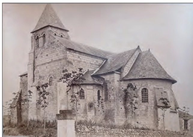
Fig. VII.4.4 - Photographie du chevet depuis le sud en 1888 par Médéric Mieusement (MPP, APMH00001306).
