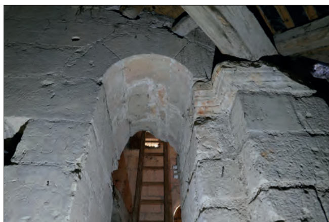
Fig. VII.4.27 - Arc de l'étage du clocher 40 010.
