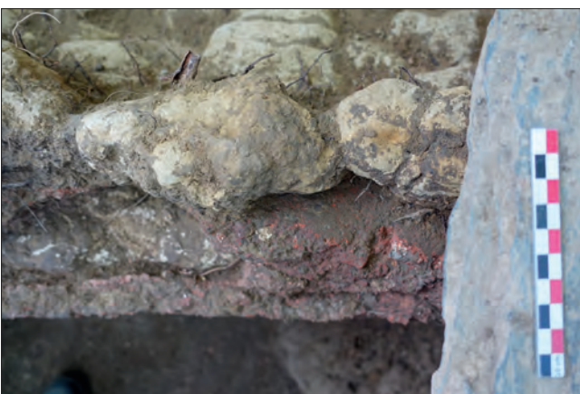
Fig. VI.2-63 – L'assise de moellons intercalée entre le quart-de-rond et les dalles de couverture, côté sud de l'aqueduc © Cliché L. Déodat 2023.
