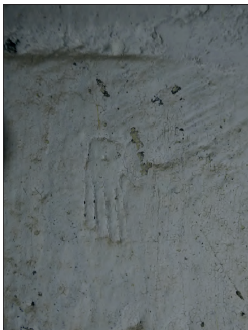
Fig. VII.4.31 - Un graffiti médiéval de main à la base du clocher (UE 40 007).
