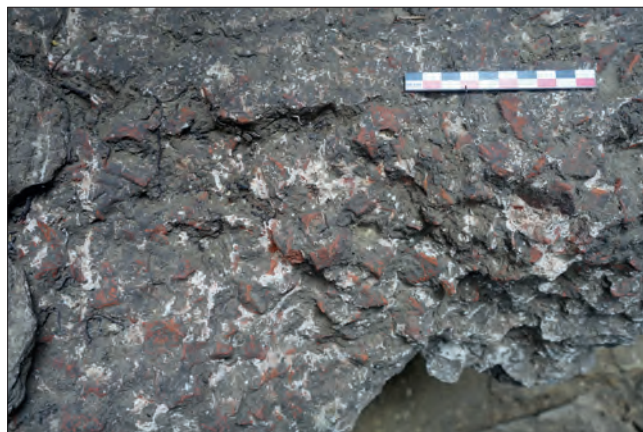
Fig. VI.2-30 - Détail du sol du specus de l'aqueduc de Mardron avec un béton similaire à celui en emploi dans le blocage du mur 10033 © Cliché L. Déodat 2022.
