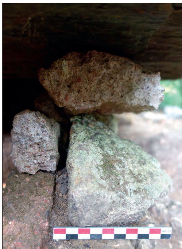
Fig. VI.2-58 - Le quart-de-rond de la paroi nord avec un mortier de composition différente © Cliché L. Déodat 2023.
