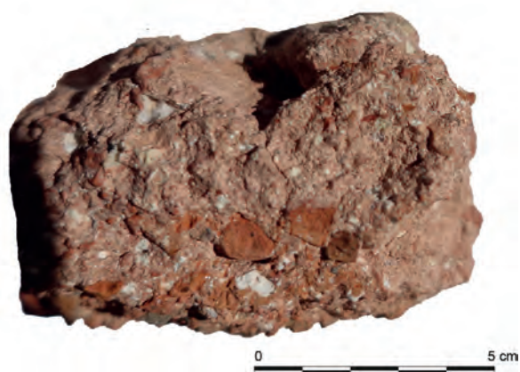
Fig. VI.2-51 - Prélèvement d'un fragment d'enduit montrant la superposition de deux couches bien différentes : un béton côté intérieur, sur la surface d'écoulement, et un mortier côté extérieur, au contact des piédroits © Cliché L. Déodat 2023.
