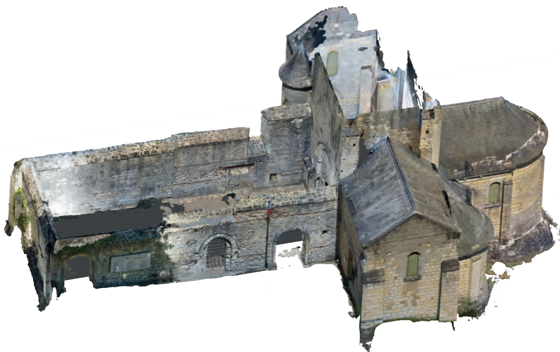
Fig. IV-19 - Représentation 3D de l'église à partir d'une photogrammétrie au drone © Réalisation D. Morleghem.
