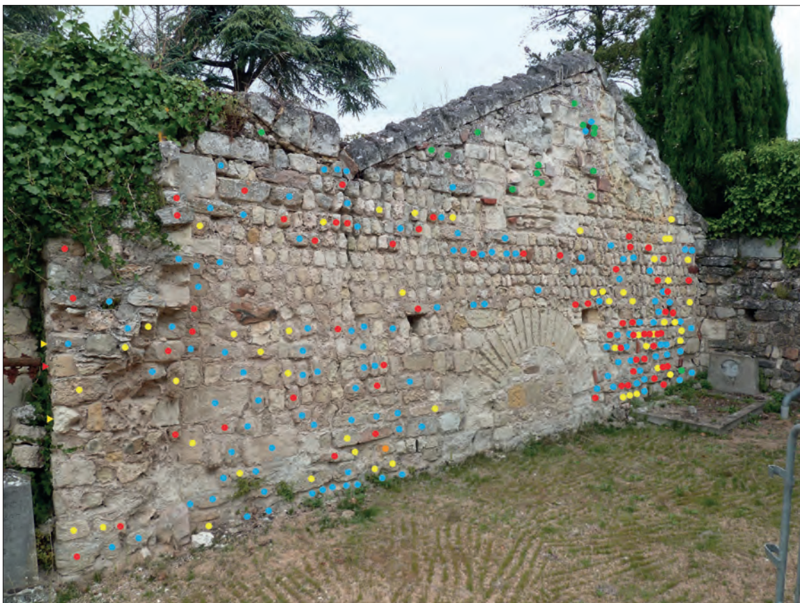
Fig. VII.5-7 - Fragments de sarcophages réemployés dans le parement intérieur du mur occidental de l'église Saint-Pierre : calcaire SP1 en bleu, calcaire SP2 en jaune, calcaire SP3 en rouge, SP4 en orange et calcaire indéterminé en vert. Les triangles représentent les fragments non visibles sur le cliché photographique © Cliché A. Polinski, 2023.
