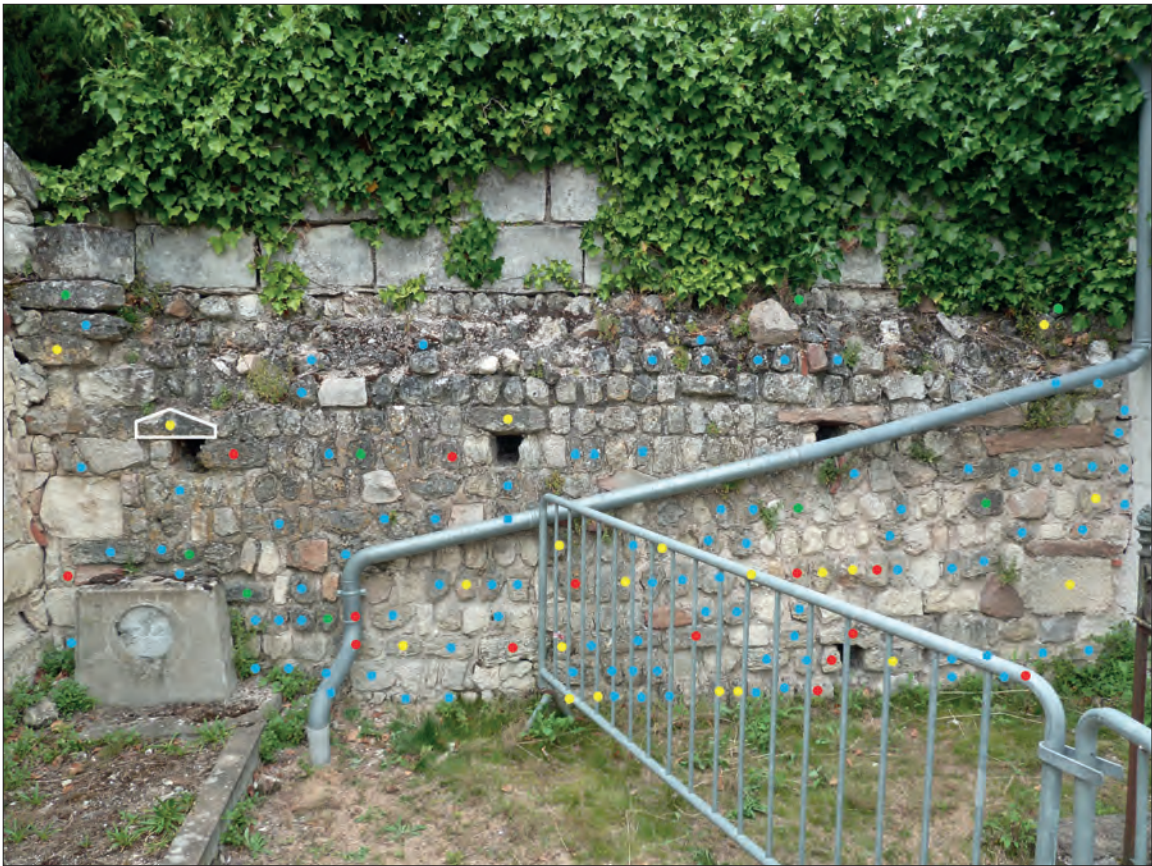
Fig. VII.5-4 - Fragments de sarcophages réemployés dans le parement intérieur du mur septentrional de l'église Saint-Pierre, au niveau de la portion visible à l'ouest de la chapelle : calcaire SP1 en bleu, calcaire SP2 en jaune, calcaire SP3 en rouge et calcaire indéterminé en vert © Cliché A. Polinski, 2023.
