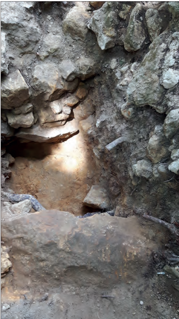
Fig. VI.2-12 - Vue depuis le sud du parement construit à l'aveugle, avec au premier plan le rocher naturel ; l'espace entre les deux a été fouillé © Cliché J. Riou.
