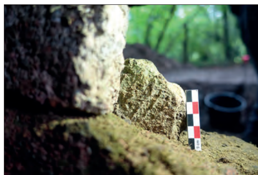
Fig. VI.2-46 - Pierre de l'assise supérieure du parement intérieur nord présentant des traces de taille au ciseau © Cliché L. Déodat 2023.
