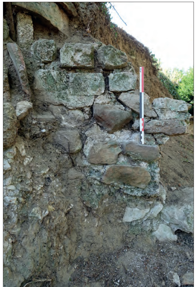
Fig. IV-13 - Le mur antique dans son élévation la plus complète © Cliché L. Déodat 2022.
