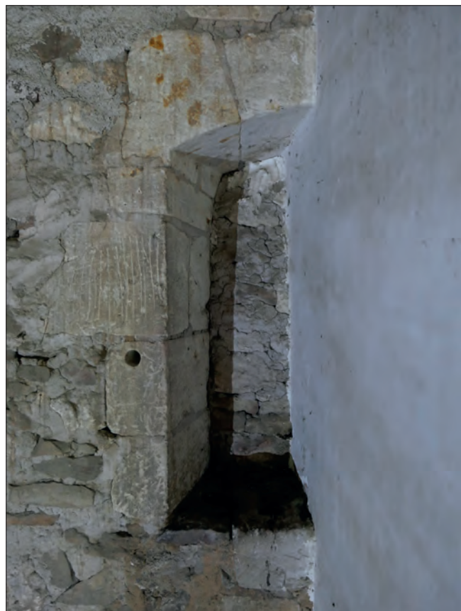
Fig. VII.3-5 - Vue de l'encadrement intérieur de la fenêtre située dans la partie sud de la façade ouest du volume principal © Cliché E. Litoux.
