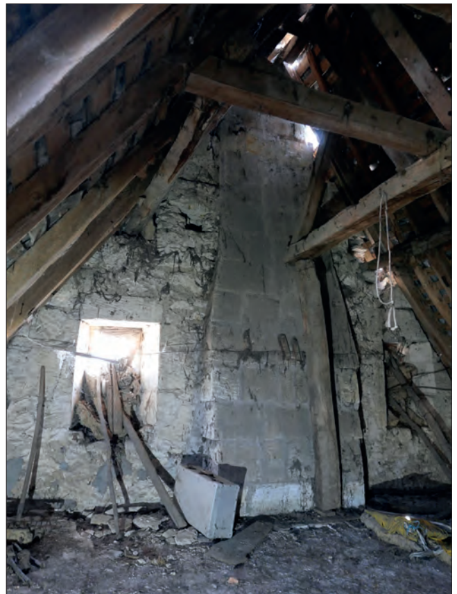
Fig. VII.3-8 - Vue du revers du mur pignon nord du volume principal © Cliché E. Litoux.
