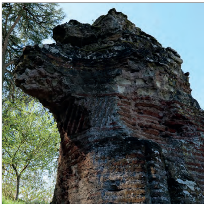
Fig. VI.3-15 - Vue en contre-plongée depuis le nord-est de l'amorce de niche partiellement conservée au contact du massif d'angle sud de l'abside 1002 © Cliché Y. Bernard, Virtual-Archéo, avril 2021.
