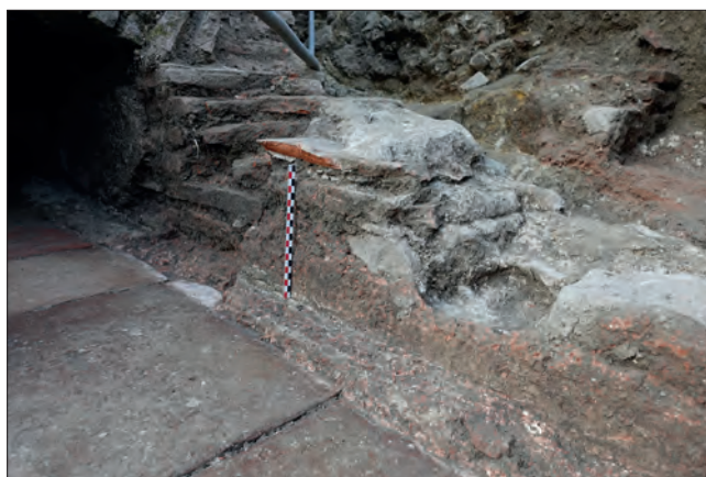
Fig. VI.3-54 – Détail de l'enduit équipant le parement septentrional de 1026 et du solin d'étanchéité installé sur le conduit 1021 © Cliché X. Favreau, juin 2023.
