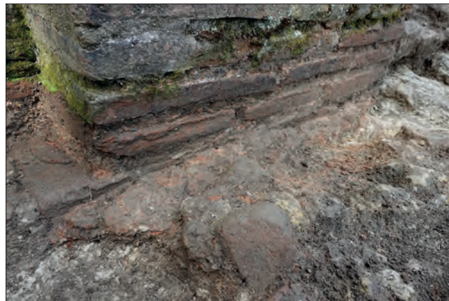
Fig. VI.3-56 – Vue depuis le nord-est du lambeau de sol 1047 recouvert par le remblai 1048 © Cliché P. Gauducheau, juin 2023.
