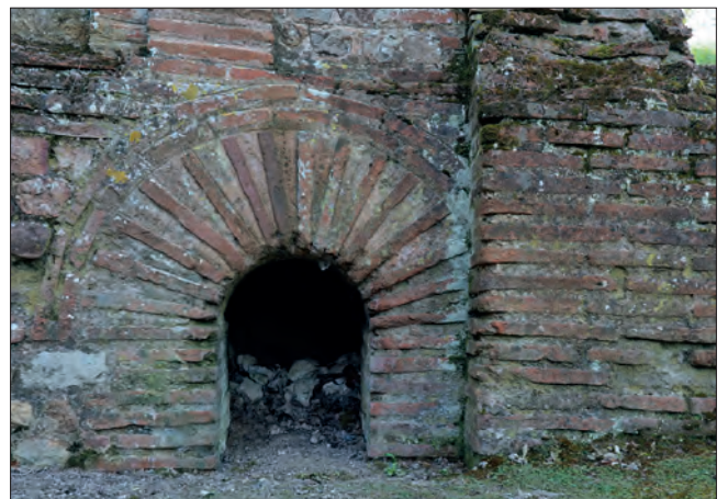
Fig. VI.3-13 - Détail du débouché nord de la conduite inférieure de l'abside 1002 © Cliché X. Favreau, mars 2021.
