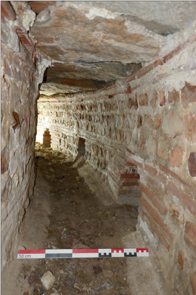
Fig. VI.3-10 - Vue de la conduite inférieure dans le soubassement de l'abside 1002 © Cliché A. Remy, octobre 2021.
