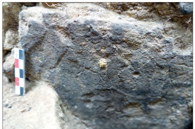
Fig. VI.2-11 - Pierre du parement nord-ouest du mur 10033, vue de face, noircie par l'action du feu © Cliché L. Déodat 2023.
