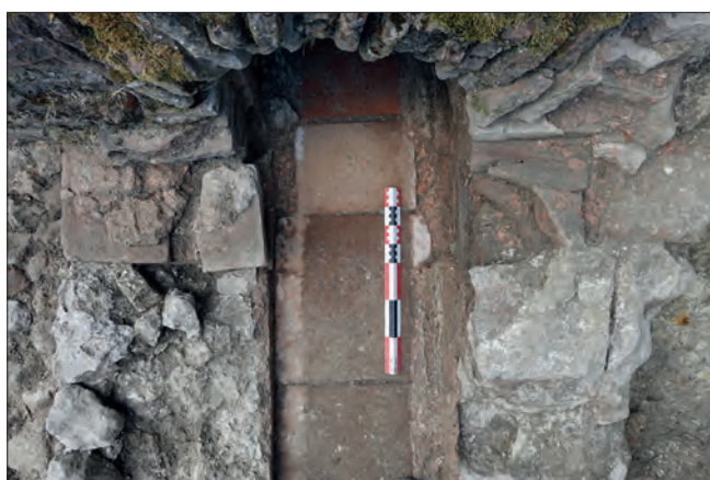
Fig. VI.3-52 – La conduite 1021 enserrée entre les maçonneries 1019 (à gauche) et 1026 (à droite). Le canal vient s'appuyer contre les piédroits d'un arc surbaissé buché appartenant à l'abside 1002 © Cliché X. Favreau, juin 2023.
