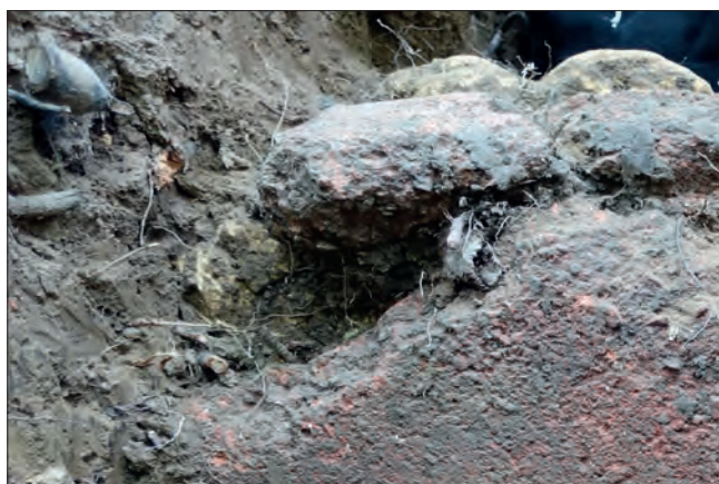
Fig. VI.2-47 - Enduit hydraulique de la paroi sud, UE 10051 © Cliché L. Déodat 2023.
