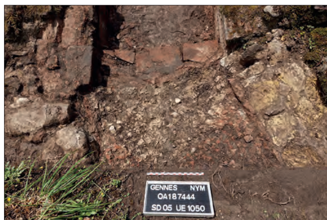
Fig. VI.3-33 – Vue depuis le nord-est de la maçonnerie 1049 qui enserre la poursuite du canal exutoire et du radier 1050 dans le conduit © Cliché M. Bellanger, juin 2023.
