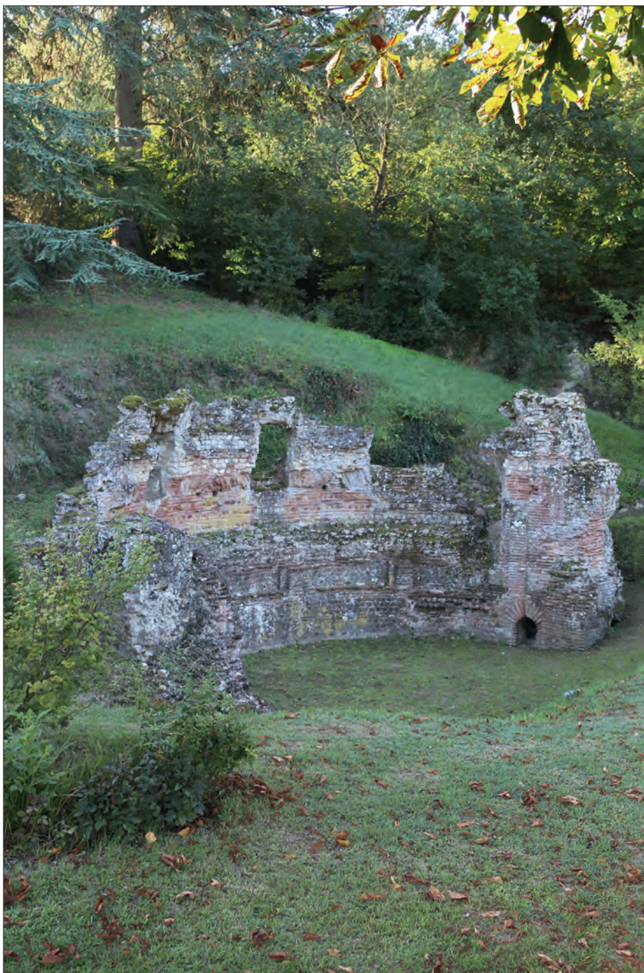
Fig. VI.3-1 - Le nymphée de Gennes dans son environnement. Vue depuis le nord © Cliché X. Favreau, septembre 2022.
