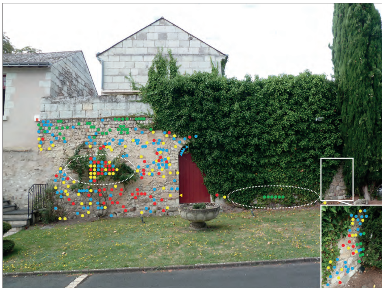
Fig. VII.5-3 - Fragments de sarcophages réemployés dans le parement extérieur du mur septentrional de l'église Saint-Pierre : calcaire SP1 en bleu, calcaire SP2 en jaune, calcaire SP3 en rouge et calcaire indéterminé en vert. Les triangles représentent les fragments non visibles sur le cliché photographique et les cercles blancs les zones pour lesquelles la position exacte des fragments n'a pas pu être restituée © Cliché A. Polinski, 2023.
