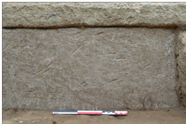
Fig. VII.2-16 - Vue rapprochée des traces de pic laissées sur la paroi gauche du sarcophage S.13 à l'occasion de la fosse d'installation du coffrage 20044 © Cliché D. Morleghem.
