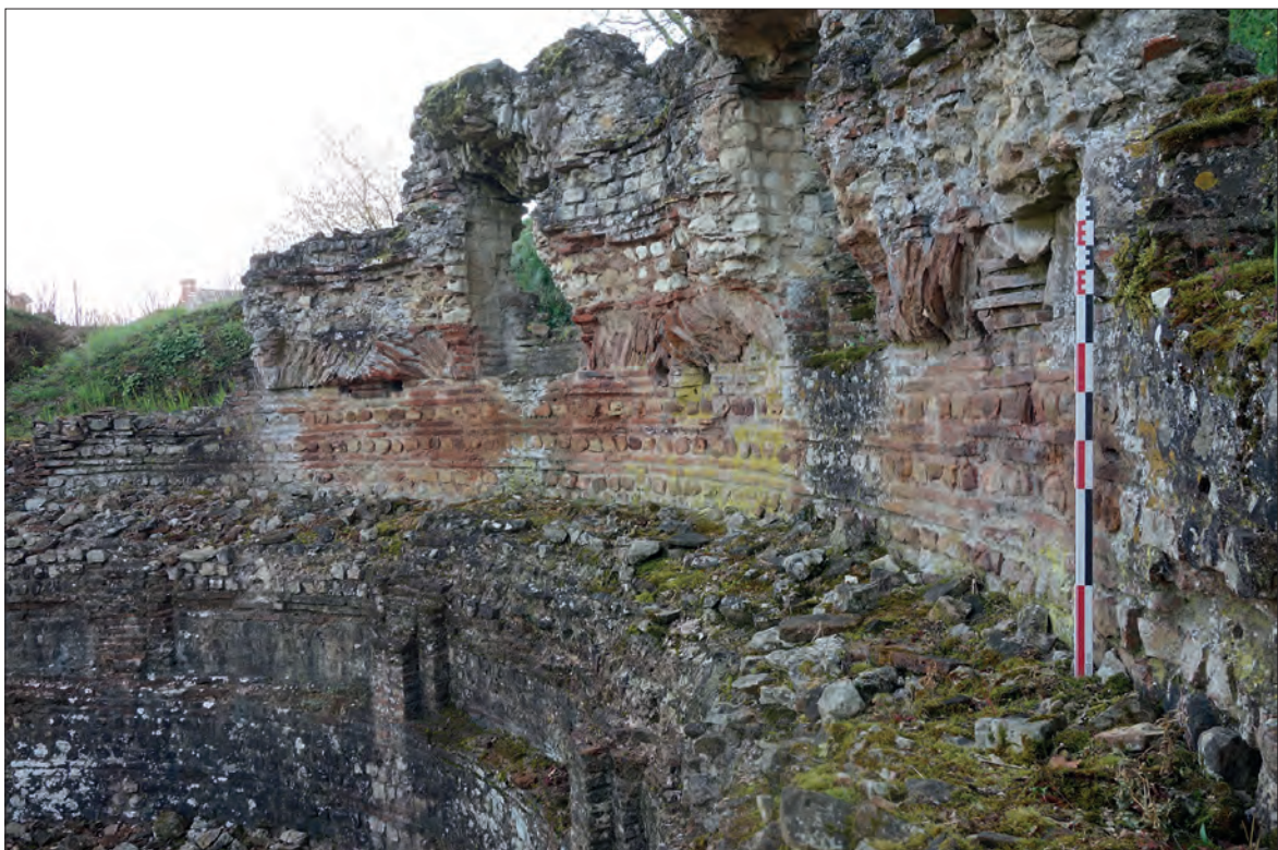
Fig. VI.3-14 - Vue depuis le sud du parement conservé de la conduite supérieure, surmonté par le registre supérieur de l'élévation de l'abside 1002 © Cliché X. Favreau, mars 2021.
