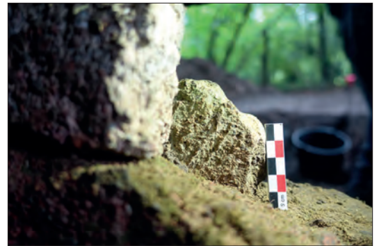
Fig. VI.2-46 - Pierre de l'assise supérieure du parement intérieur nord présentant des traces de taille au ciseau © Cliché L. Déodat 2023.
