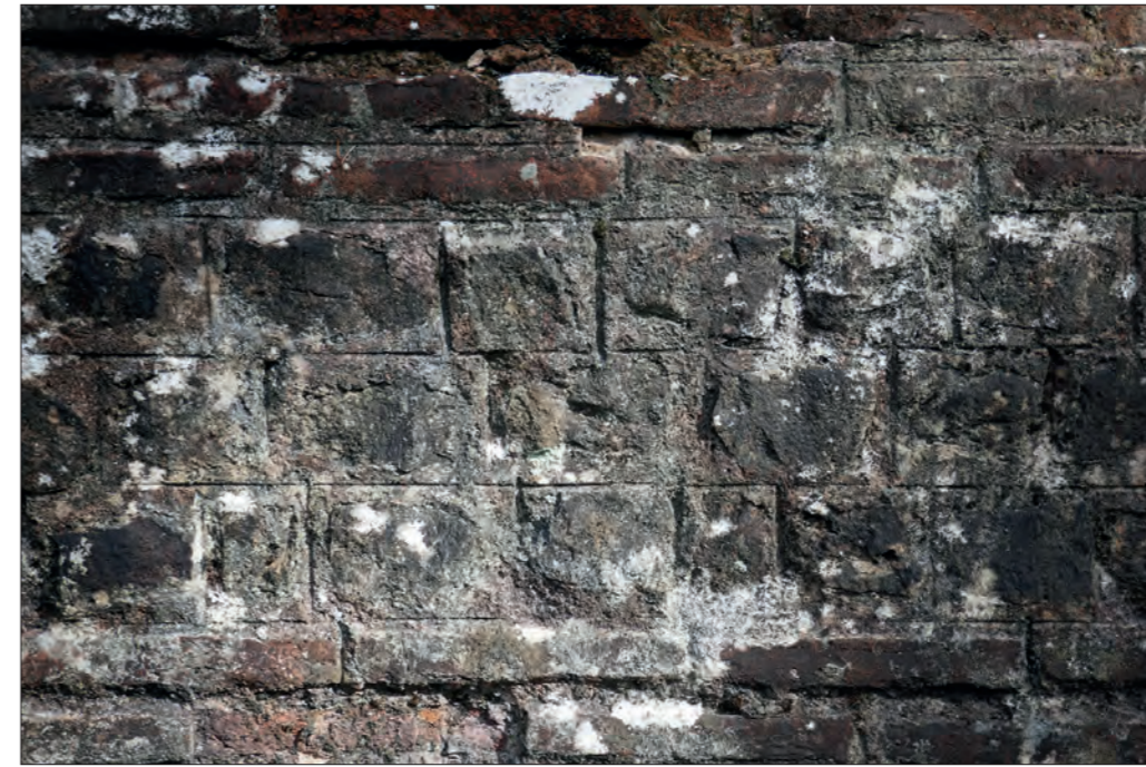
Fig. VI.3-7 - Détail du parement du registre inférieur de 1002 © Cliché A. Remy, octobre 2021.
