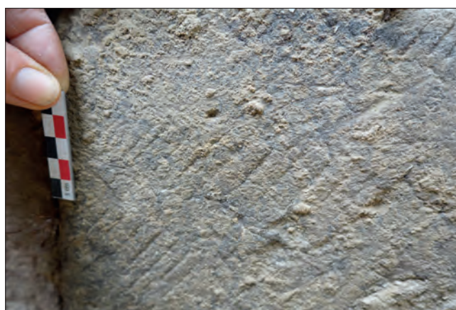
Fig. VI.2-24 - Pierre taillée appartenant à la deuxième assise du mur 10033 et présentant un layage caractéristique du XIII e s. © Cliché L. Déodat 2023.
