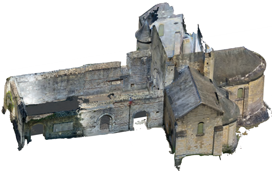
Fig. IV-19 - Représentation 3D de l'église à partir d'une photogrammétrie au drone © Réalisation D. Morleghem.
