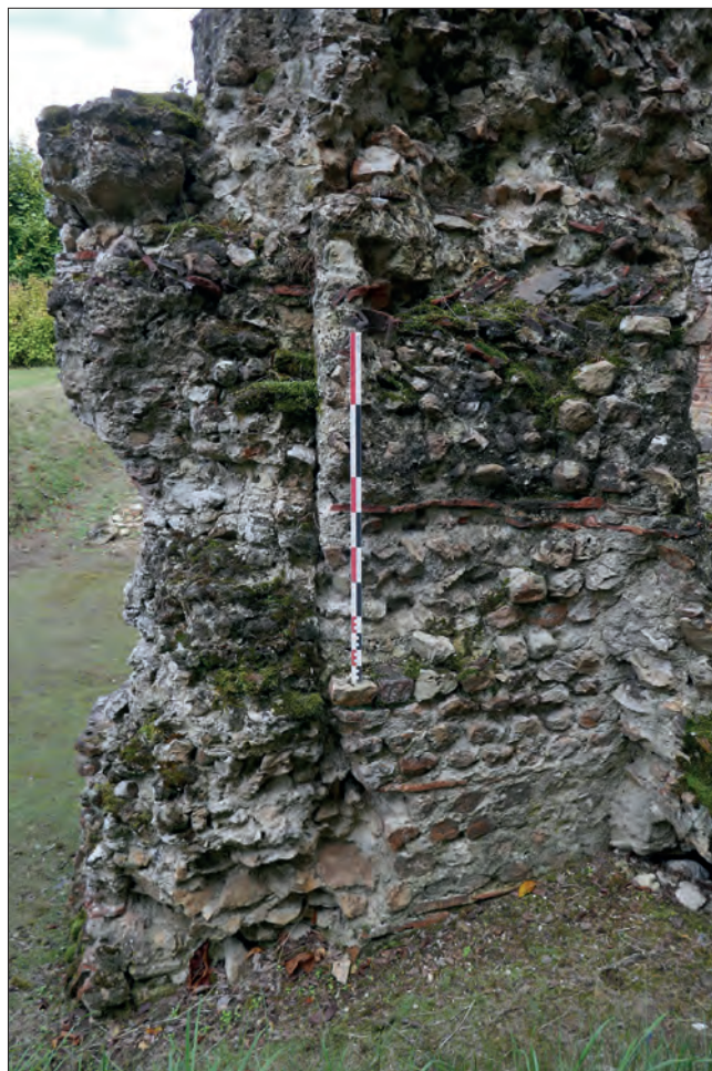
Fig. VI.3-4 - Vue du massif d'angle sud, depuis le sud-ouest. À droite du coup de sabre : le parement extérieur du mur 1002 ; à gauche : l'arrachement du mur 1001 © Cliché A. Remy, octobre 2021.
