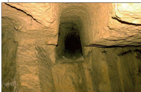
Fig. IV-33 - Souterrain aménagé alto-médiéval présent dans les carrières de Saint-Eusèbe, site de La Cave Forte © Cliché M. Cousin.
