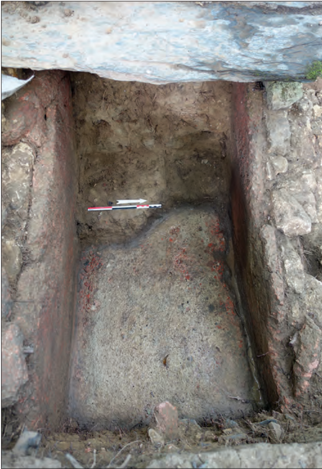
Fig. VI.2-54 - La conduite, avec le fond du specus dégagé, au premier plan, et les couches sédimentaires laissées en place, sous la couverture © Cliché L. Déodat 2023.
