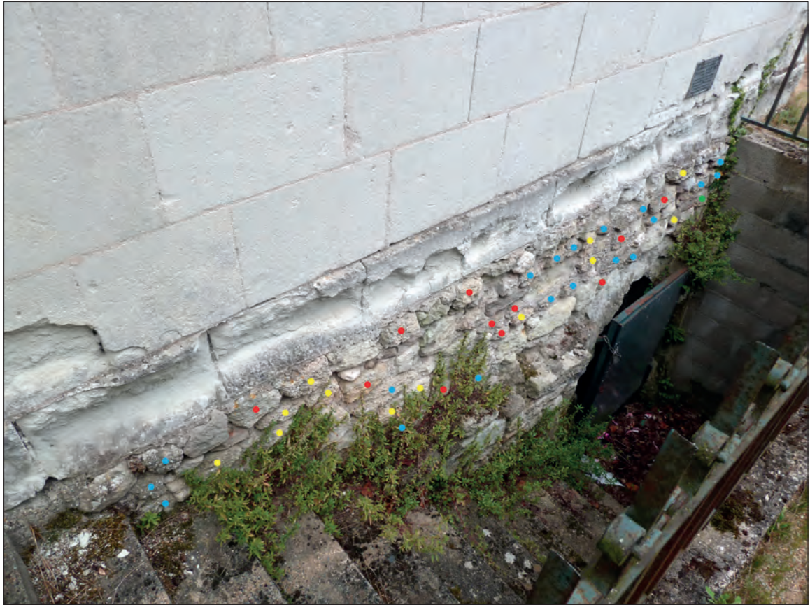
Fig. VII.5-8 - Fragments de sarcophages réemployés dans le mur occidental sous la chapelle moderne : calcaire SP1 en bleu, calcaire SP2 en jaune, calcaire SP3 en rouge et calcaire indéterminé en vert © Cliché A. Polinski, 2023.
