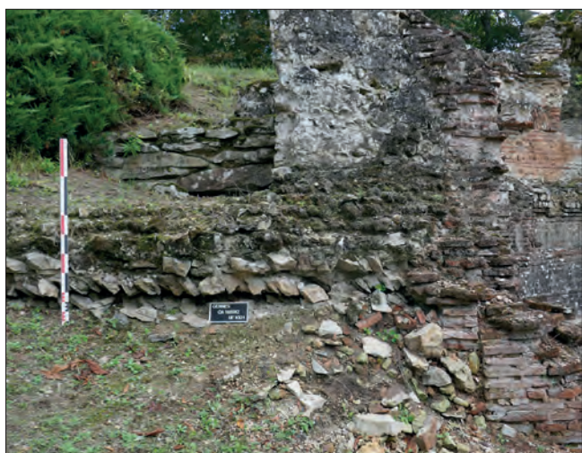
Fig. VI.3-3 - Fondation apparente du mur 1001 © Cliché A. Remy, octobre 2021.
