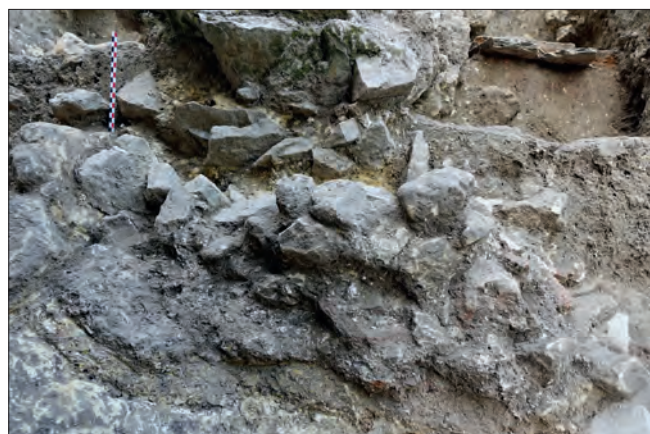
Fig. VI.3-64 – Détail du remblai de bouchage 1036 © Cliché P. Gauducheau, juin 2023.
