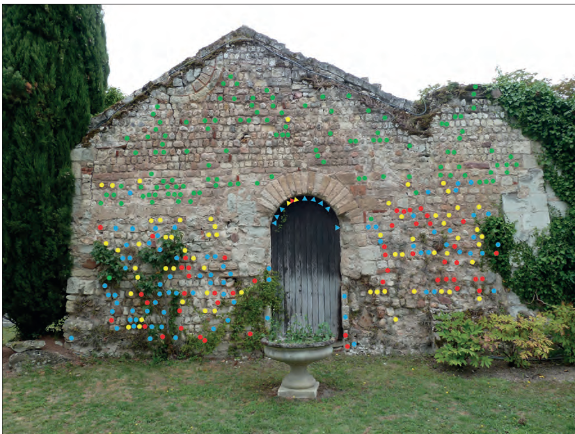
Fig. VII.5-6 - Fragments de sarcophages réemployés dans le parement extérieur du mur occidental de l'église Saint-Pierre : calcaire SP1 en bleu, calcaire SP2 en jaune, calcaire SP3 en rouge et calcaire indéterminé en vert. Les triangles représentent les fragments non visibles sur le cliché photographique © Cliché A. Polinski, 2023.
