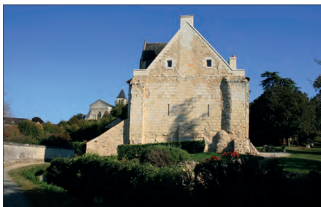
Fig. VI.2-28 - Le mur nord du manoir de Mardron avec sa partie ancienne : contreforts plats et fentes de jour attribuables au XII e ou XIII e s. © Cliché L. Déodat 2019.
