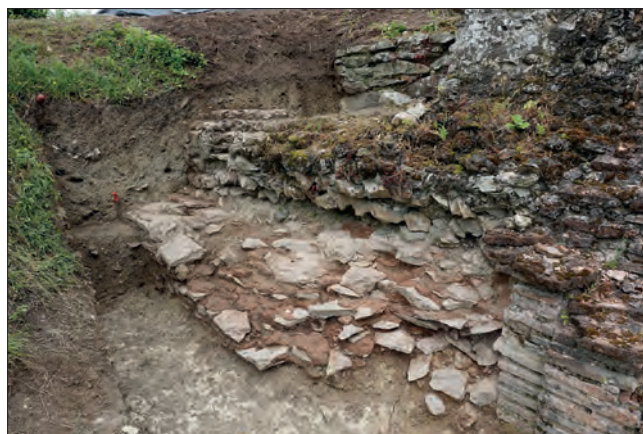
Fig. VI.3-40 – Vue depuis l'ouest de la maçonnerie 1034 reprenant en sous-œuvre le mur 1001 © Cliché X. Favreau, juin 2023.
