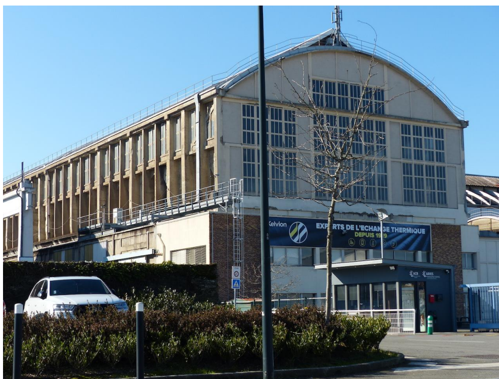
Photographie 6 : Grande nef (surnommée « la Cathédrale » par les ouvriers) de l'usine de Batignolles, actuellement occupée par l'entreprise Kelvion (crédit : Arnaud de Lajartre)
