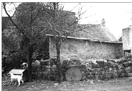
Fig. 53 – Cussy-le-Châtel : la base de la tour du XIII e s. a été épargnée pour servir de support à la cuve à gasoil
