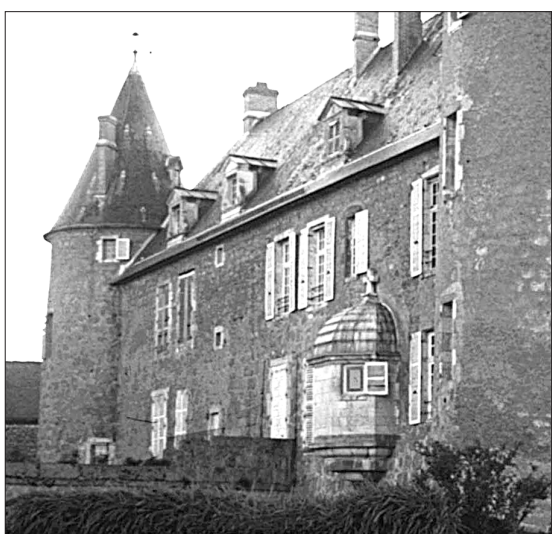
Fig. 221 – La Roche-en-Brenil : chœur de la chapelle en encorbellement
