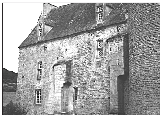
Fig. 220 – Villiers (Pouillenay) Latrines sur contreforts-conduits
