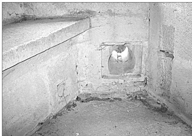
Fig. 124 – Lamargelle : canonnière pour pièce semi-lourde, fin XIV e s.
