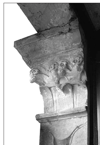
Fig. 135 – Touillon : chapiteau de la tour
