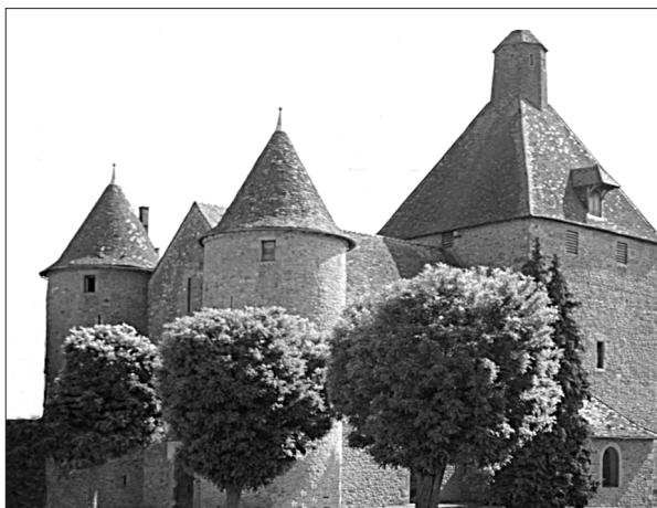
Fig. 93 – Église forte de Manlay
