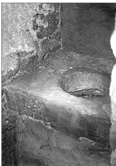
Fig. 216 – Tour de Conforgien Siège de latrines, XIII e s.
