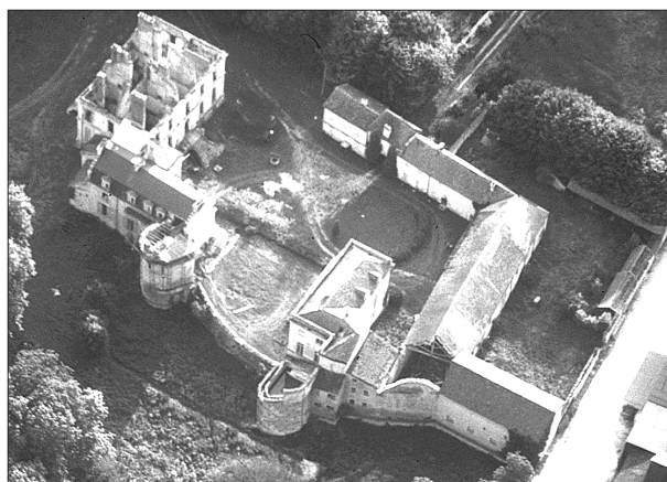
Fig. 109 – Maison forte de Crépan, vue de l'est
