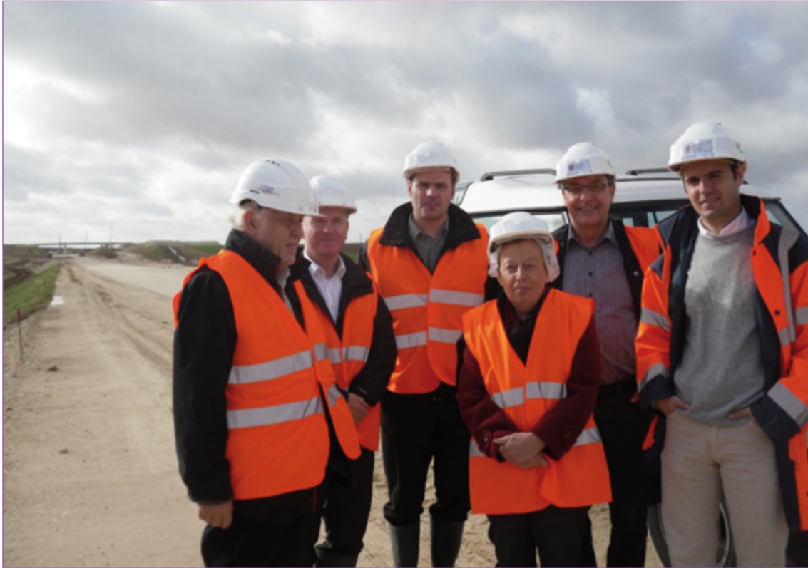
Sur le chantier de la ligne à grande vitesse Sud Europe atlantique Visite organisée dans le cadre de l'Observatoire socio-économique de la LISEA.
