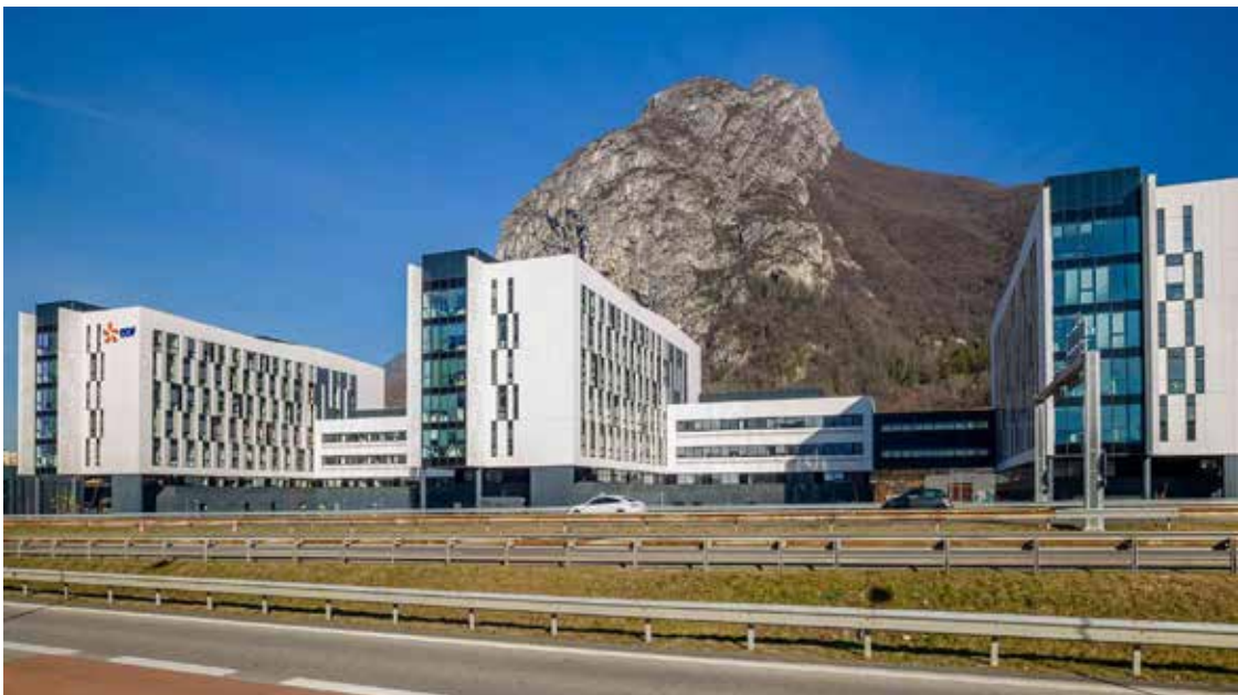
Photo du Pôle hydraulique EDF de Saint-Martin-le-Vinoux. Source : Site internet de GA Smart Building.
