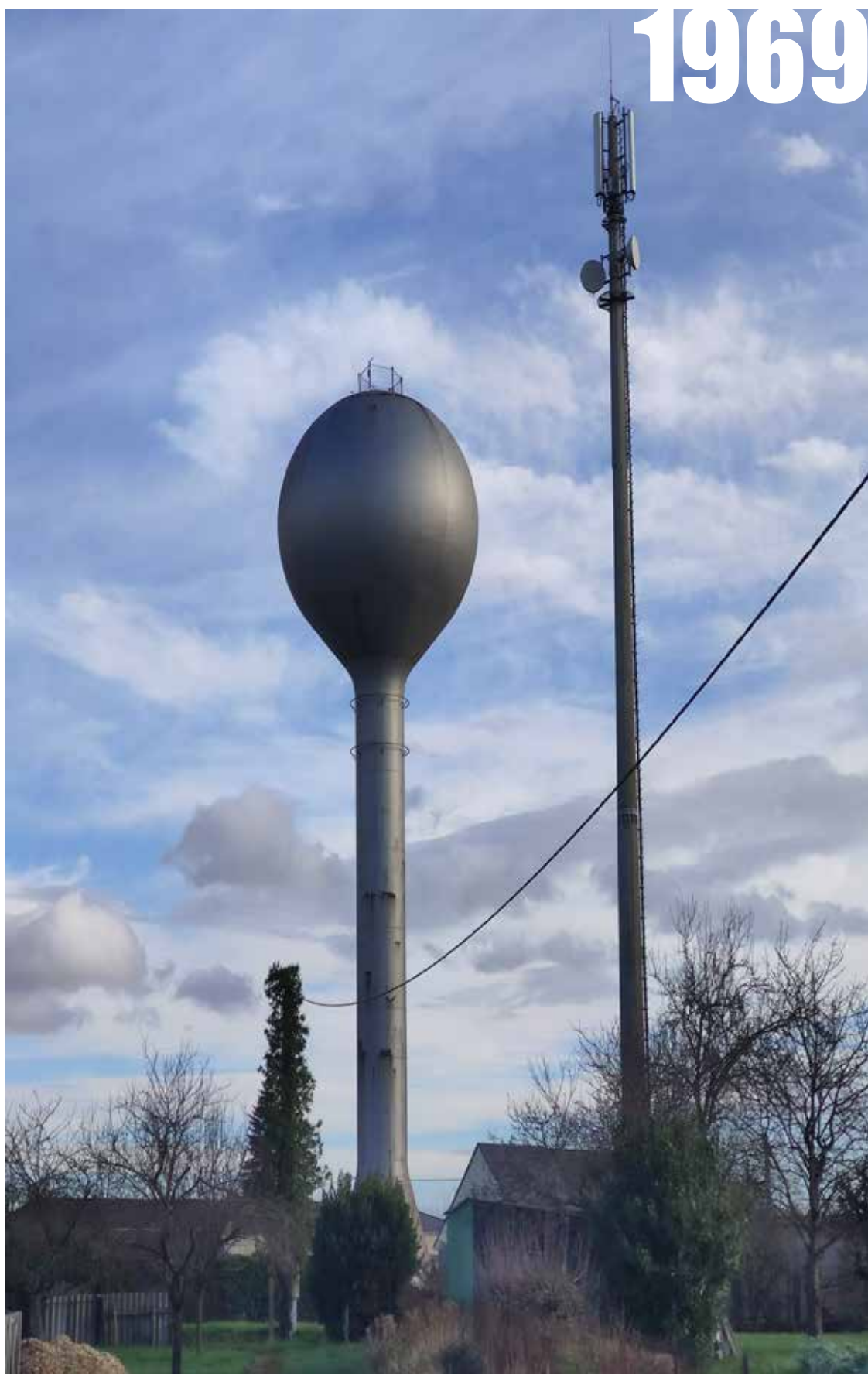
Le château d'eau sphérique métallique de Mondoubleau (41) cliché pris par l'auteur le 29 juin 2020
