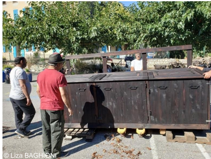
Construction d'un compost 3 bacs.
