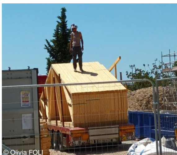
Charpentier réceptionnant des éléments d'ossature bois.
