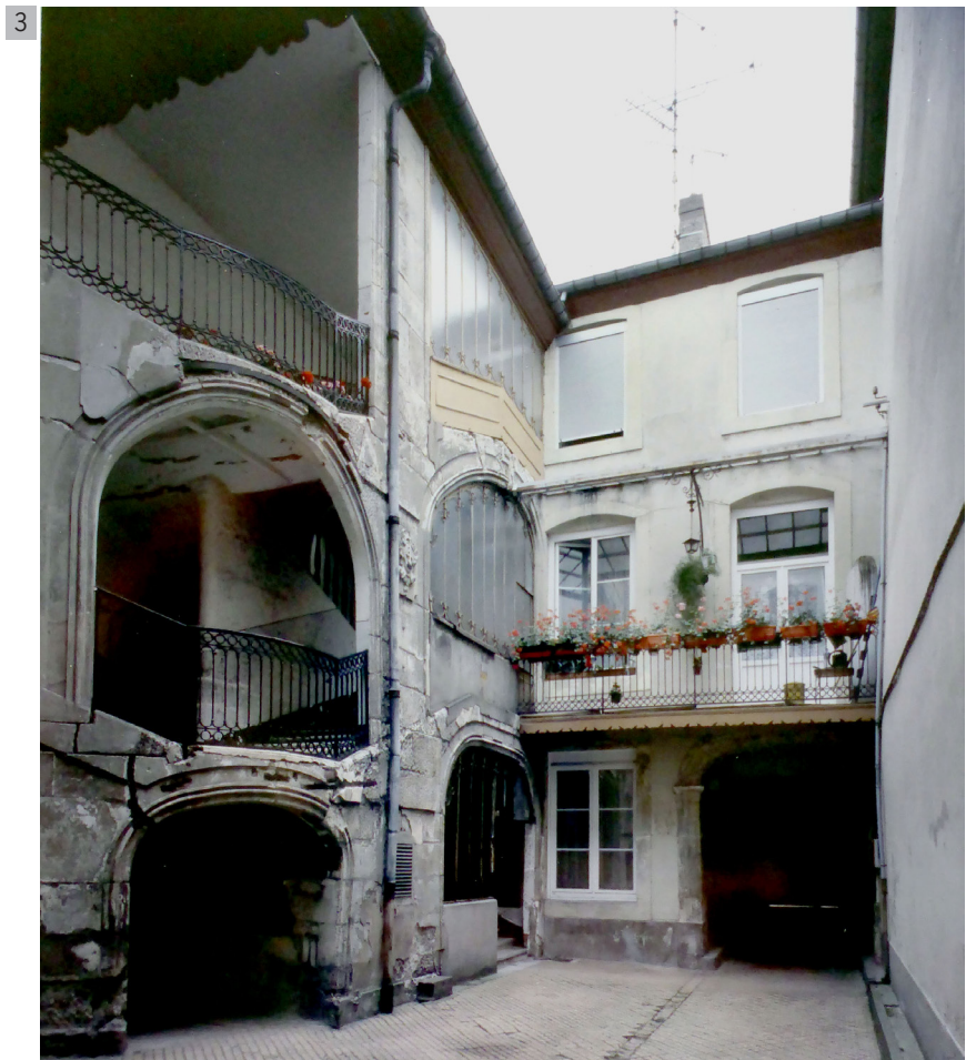
Fig. 3 - Lunéville (54), 45, rue de la République, corps de bâtiment sur rue, façade postérieure, SRI Lorraine, dossier IA00121657. (Cliché A. George, s.d.)
