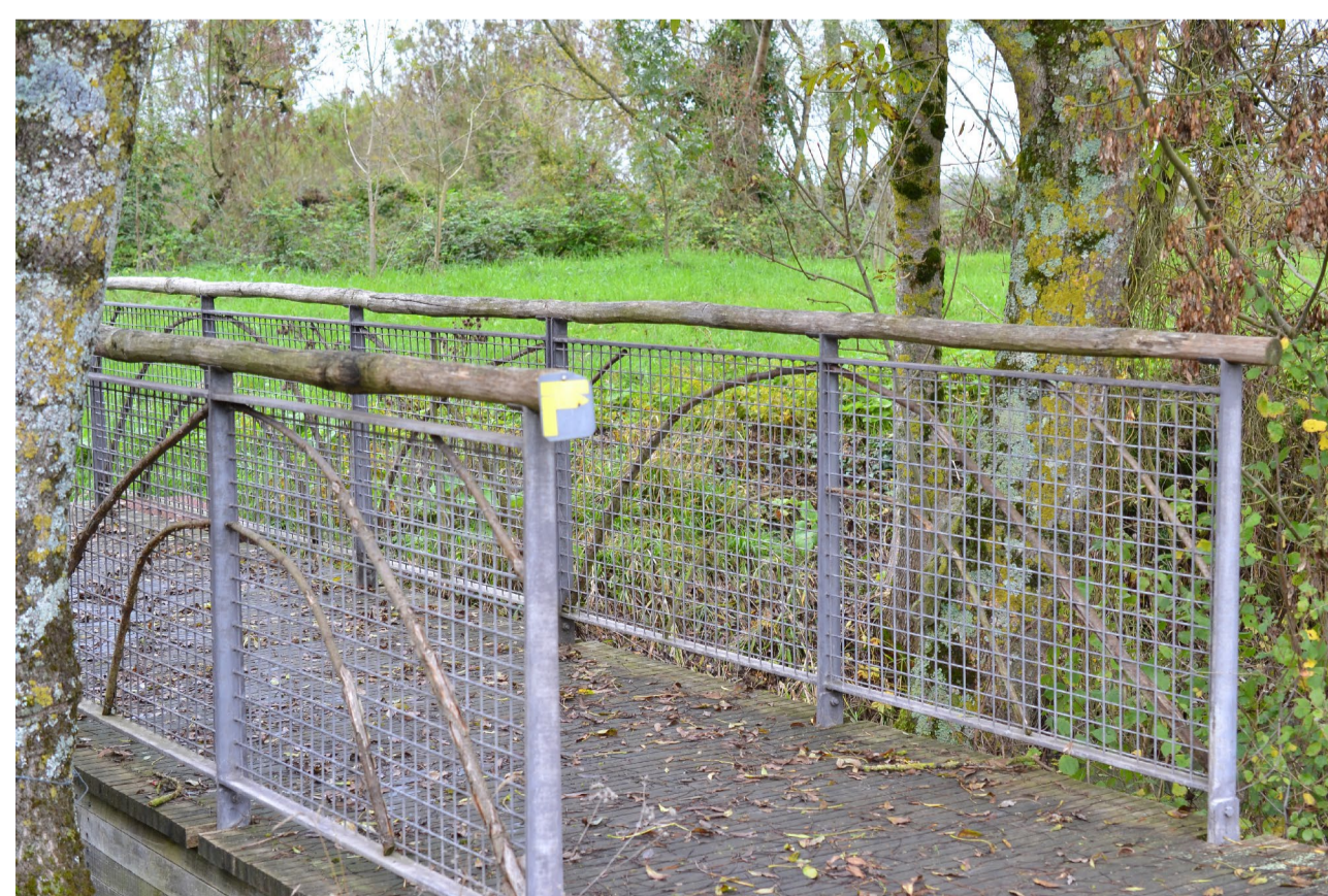
Passerelle enjambant l'achenal sur le sentier des Bois Blancs (Saint-Pierre-le-Vieux, octobre 2019)
