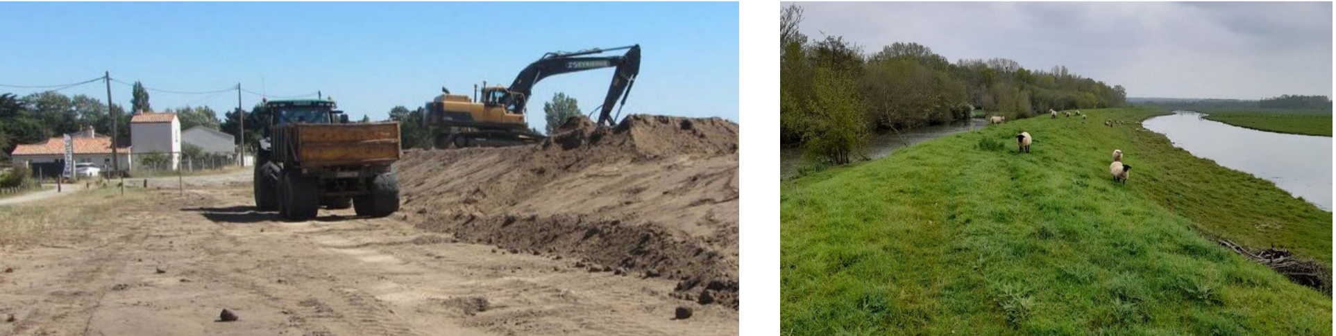
Réhaussement des digues du Lay à l'Aiguillon-sur-mer (Source : Ouest-France, juillet 2020). Entretien des digues par pâturage ovin, pour limiter la végétation et mieux surveiller l'état des digues (source : bassindulay.fr).
