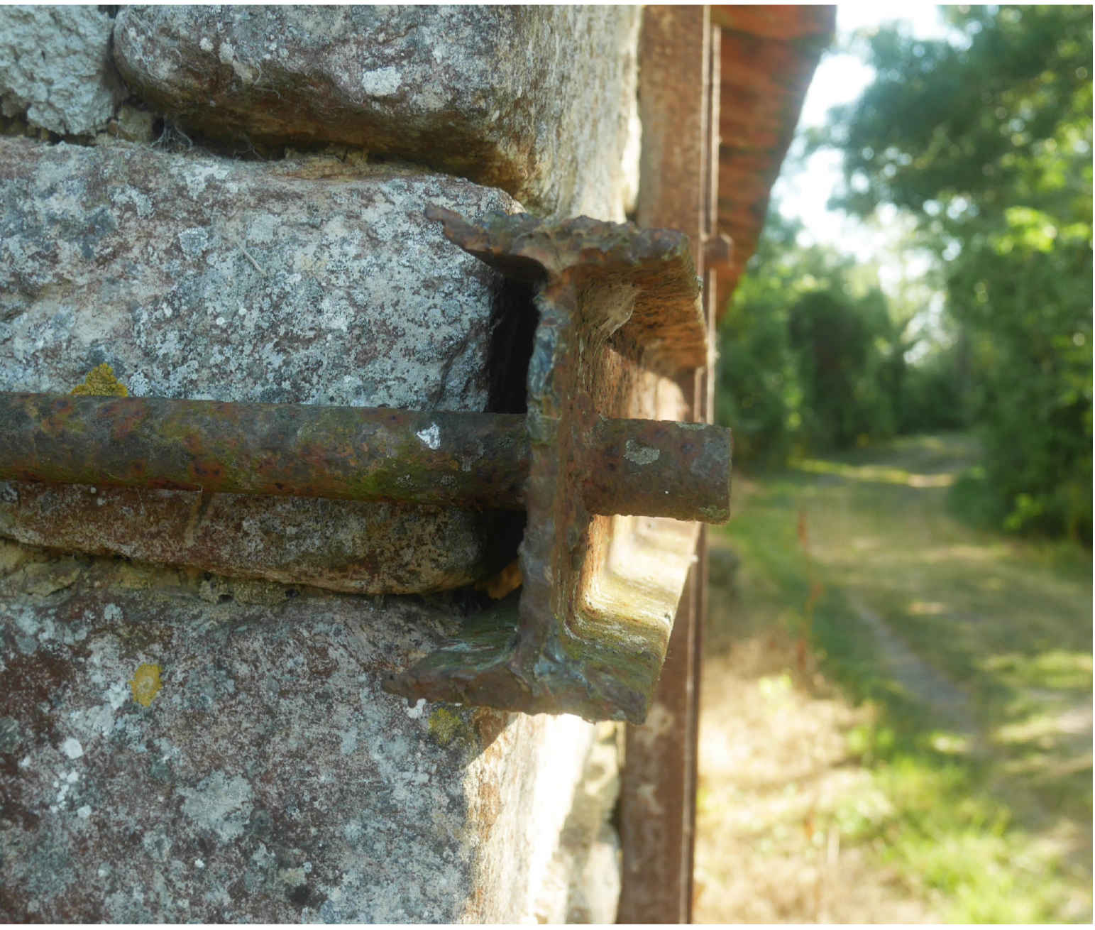
Tirants métalliques installés pour maintenir la stabilité du bâti (entre Maillé et Maillezais, levée de la Bourse de Chaix, juillet 2019, photo Alexis Pernet).
