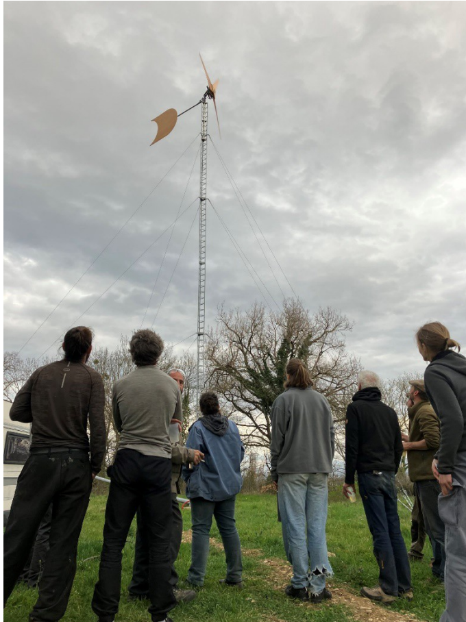
Figure 5 : éolienne de 4m20 sur un mât de 24m - Source : photo personnelle
