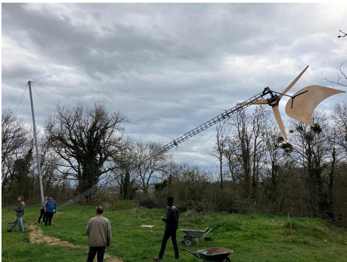
Figure 2 : éolienne en drapeau lors du montage - Source : photo personnelle
