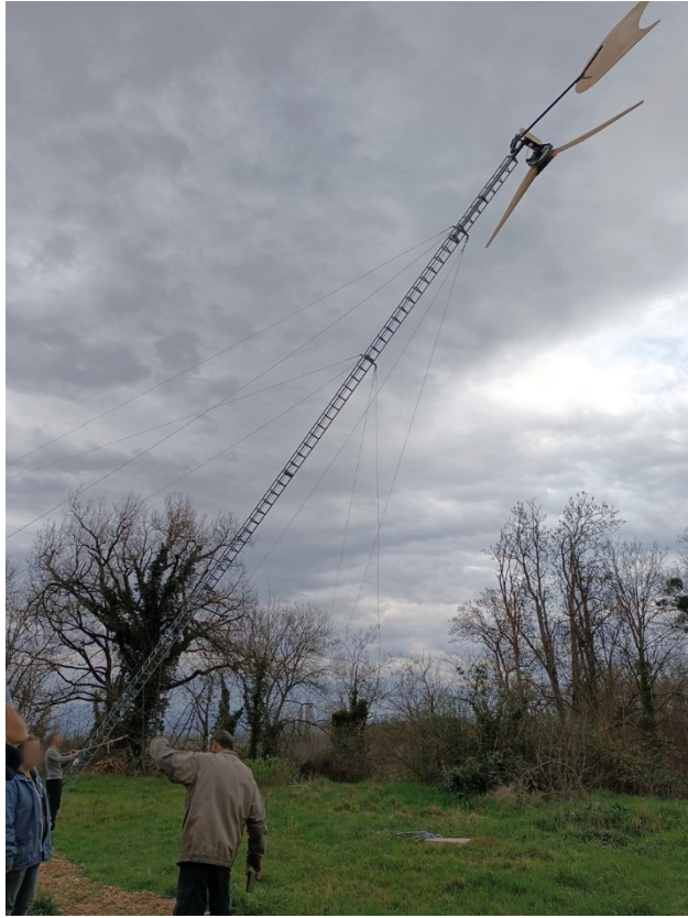
Figure 3 : éolienne en drapeau lors du montage - Source : photo personnelle
