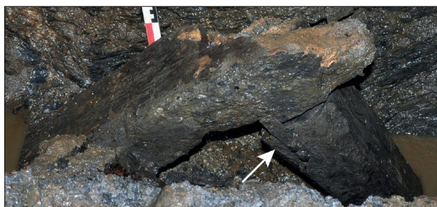
Fig. 15. Les Ouels, timbers joined with a flat iron from Adit +19, 15th century. Obr. 15. Les Ouels, dřeva spojená s plochým železem ze štoly +19, 15. století.
