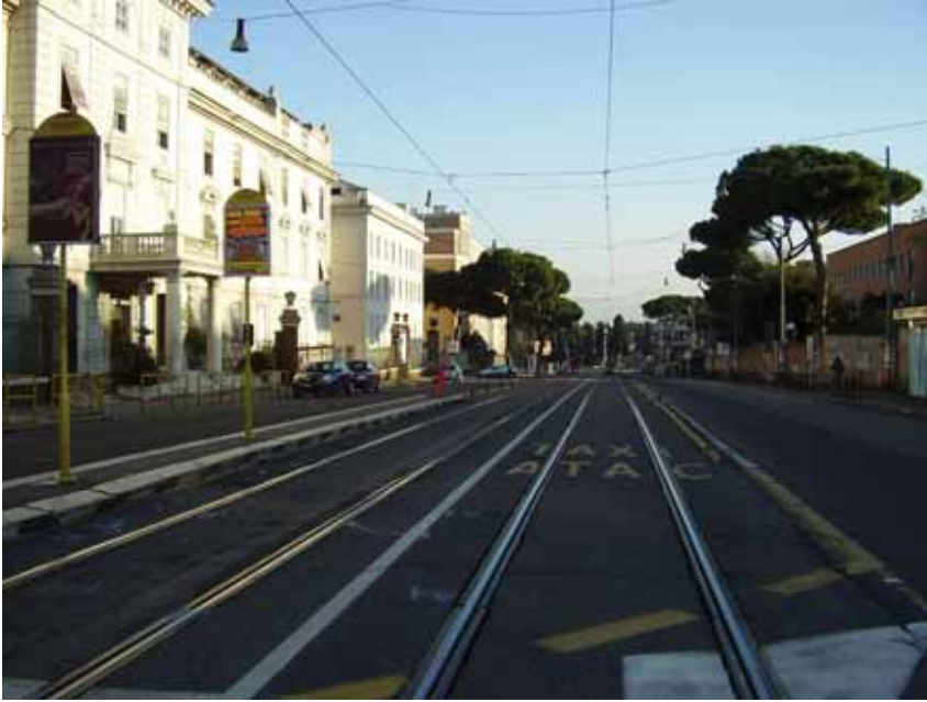
Fig. 1 – Arrêts d'autobus et installations du tramway sur le Viale Regina Elena (cliché de l'auteur, mars 2008).
