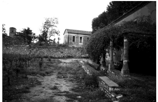
Fig. 24 : Ancienne pergola dite de la « Vigne Ramon » à l'ouest de l'ancienne abbaye, aujourd'hui démantelée (Cliché L. Schneider 1988).
