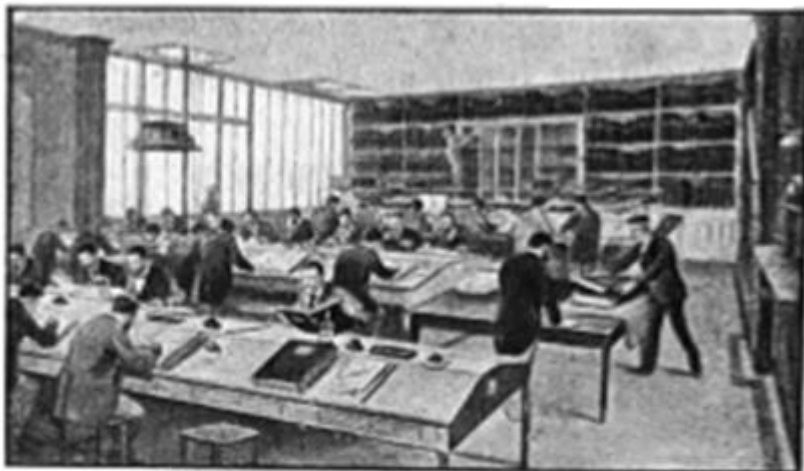
Vue des bureaux comptables.
