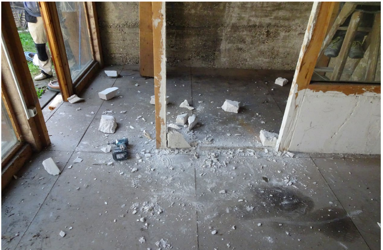
Jean Paul, habitant. Transformation d'un espace de réserve en espace habitable.
