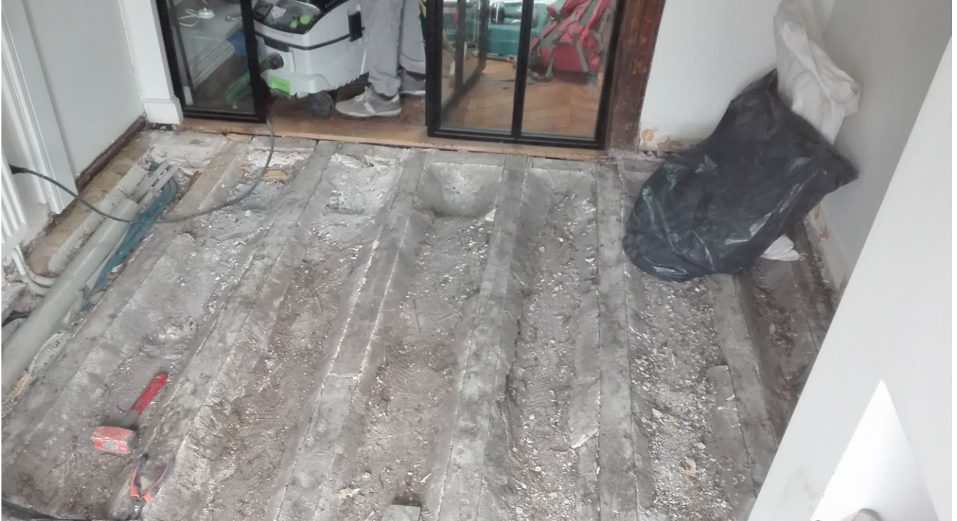
Mathieu, artisan. Passage de gaines sous le futur parquet.
