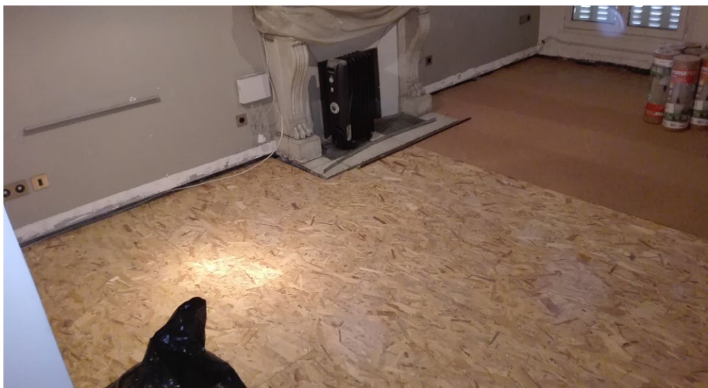
Mathieu, artisan. Rénovation d'appartement.
