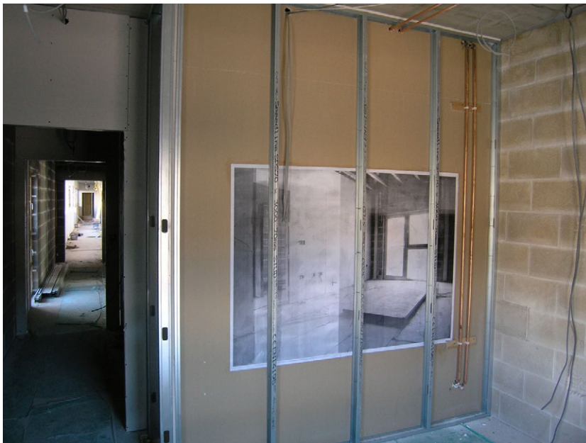
Marie-Jeanne Hoffner, Hide the Image, appartement # 2, Cabot Circus Construction Site, Bristol, UK, 2008. Pour BS1-Project, sur une invitation de Neville Gabie.
