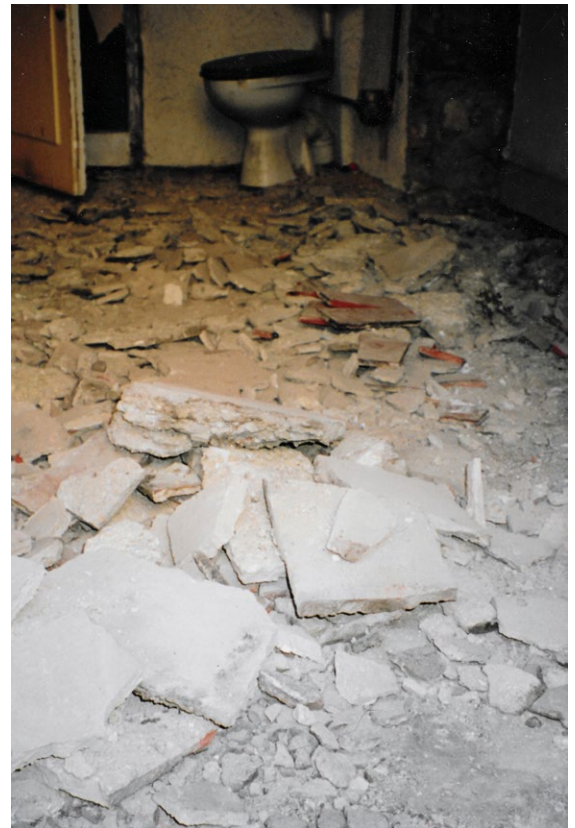
Jean Paul, habitant. Démolition de carrelage entre ami-es.
