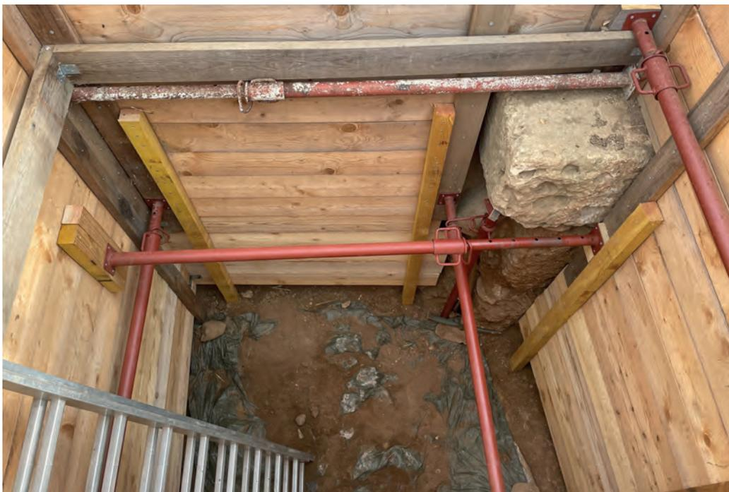
Fig. 7 : Le sondage 6 en début de campagne 2024, après démontage des bermes et prolongation du caisson de palplanches, vu du sud (© E. Gaillardat).
