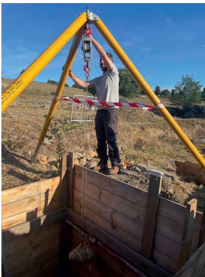
Fig. 8 : Le treuil installé à l'aplomb du sondage 6 (© A. Vacheret).
