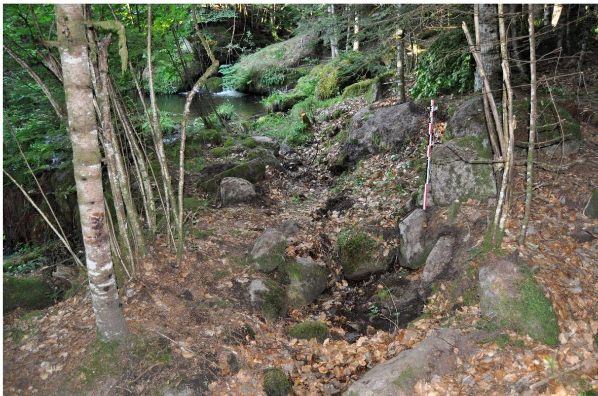
Figure 62 : Aménagement de la prise d'eau du canal d'amenée, état actuel. La prise est matérialisée par deux alignements de blocs de granite (centre du cliché). La vasque d'eau est visible en arrière plan. Prise de vue vers l'ouest
