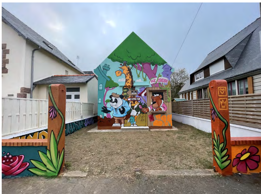
Décoration du poste électrique à Hellio-Bily, réalisée lors d'un atelier impliquant des adolescents du quartier et le graffeur Kevin Bidault (©Kevin Bidault)
