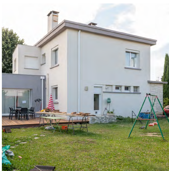
Construction d'une terrasse maison T6
