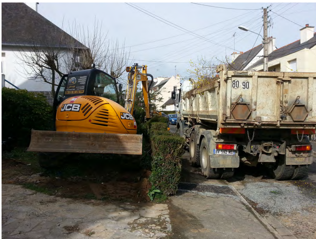
Le chantier d'arrachage chez SB4 (photo propriétaire)
