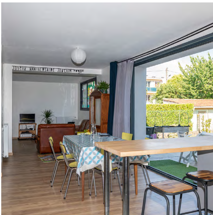
Salon (T3) : on peut noter l'absence de protection solaire extérieure pour la baie vitrée
