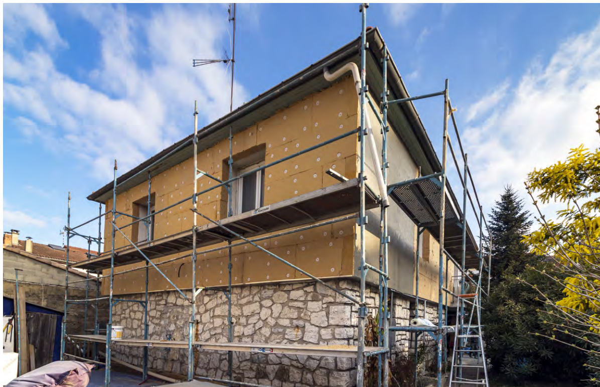
Une isolation performante conservant le sous-bassement en pierre, sur un chantier Dorémi (©Virginie Fraisse)
