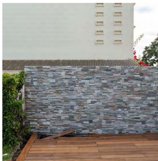
Construction d'une terrasse maison T6
